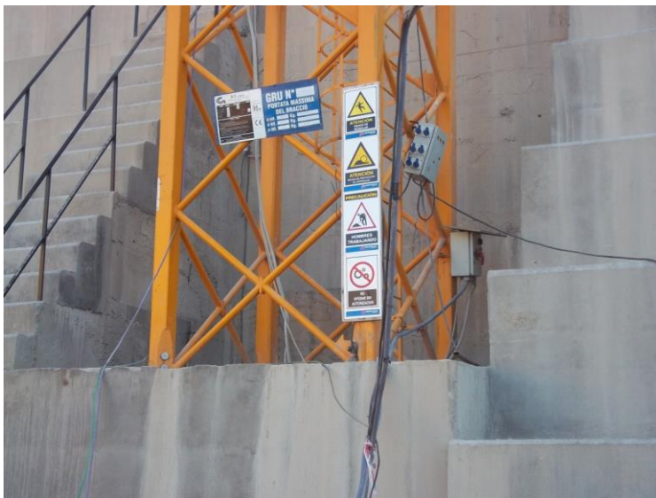
Indicaciones en el tanque de combustible, obligatoriedad de utilizar EPP y equipo de seguridad.
