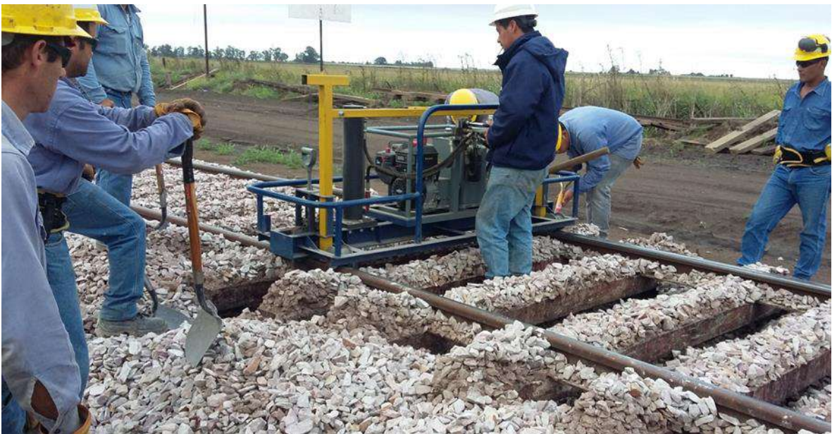
Gatos hidráulicos para la realización de levante de vía
