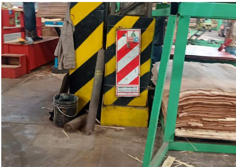
Imagen 1 Foto del sector donde debería estar en condiciones el extintor y no lo está.
