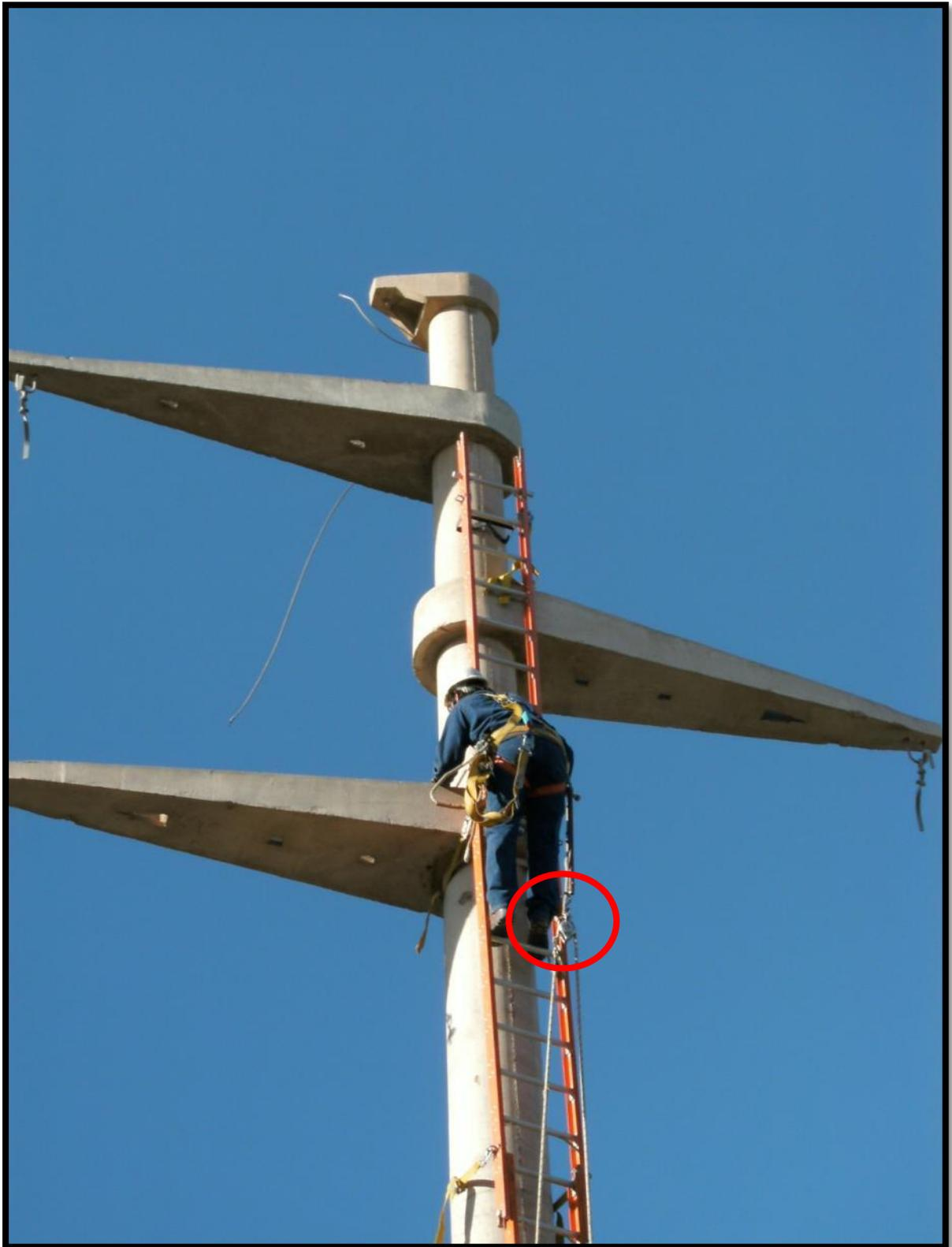
Podemos apreciar la soga de servicio y la roldana, mediante la cual se realiza el ascenso y descenso de los tramos de la escalera.
