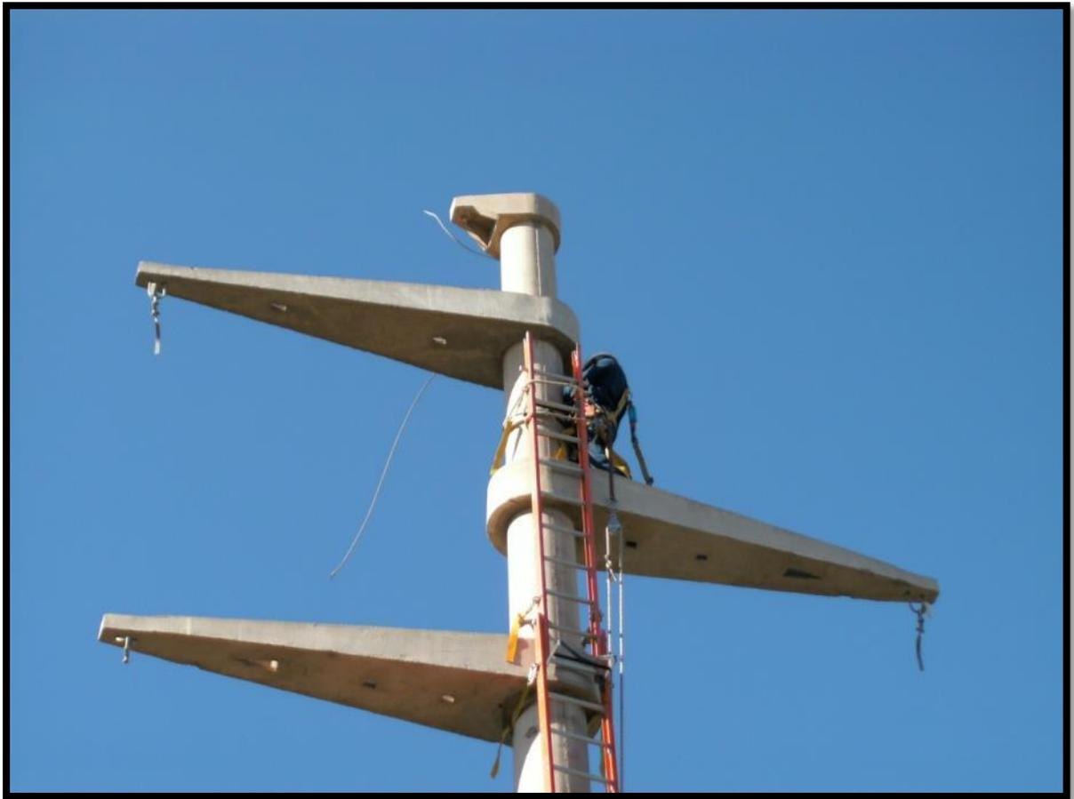
En esta imagen se observa cómo el operador sujeta la sogá de servicio a la estructura para el ascenso y descenso de las herramientas.
