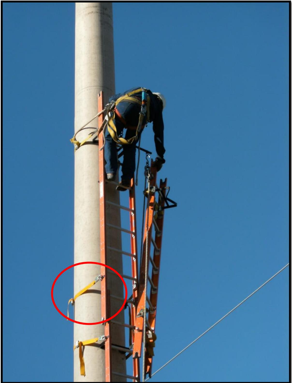
En la imagen se pueden observar los cabos de amarre con los que se realiza la sujeción de la escalera a la columna.
