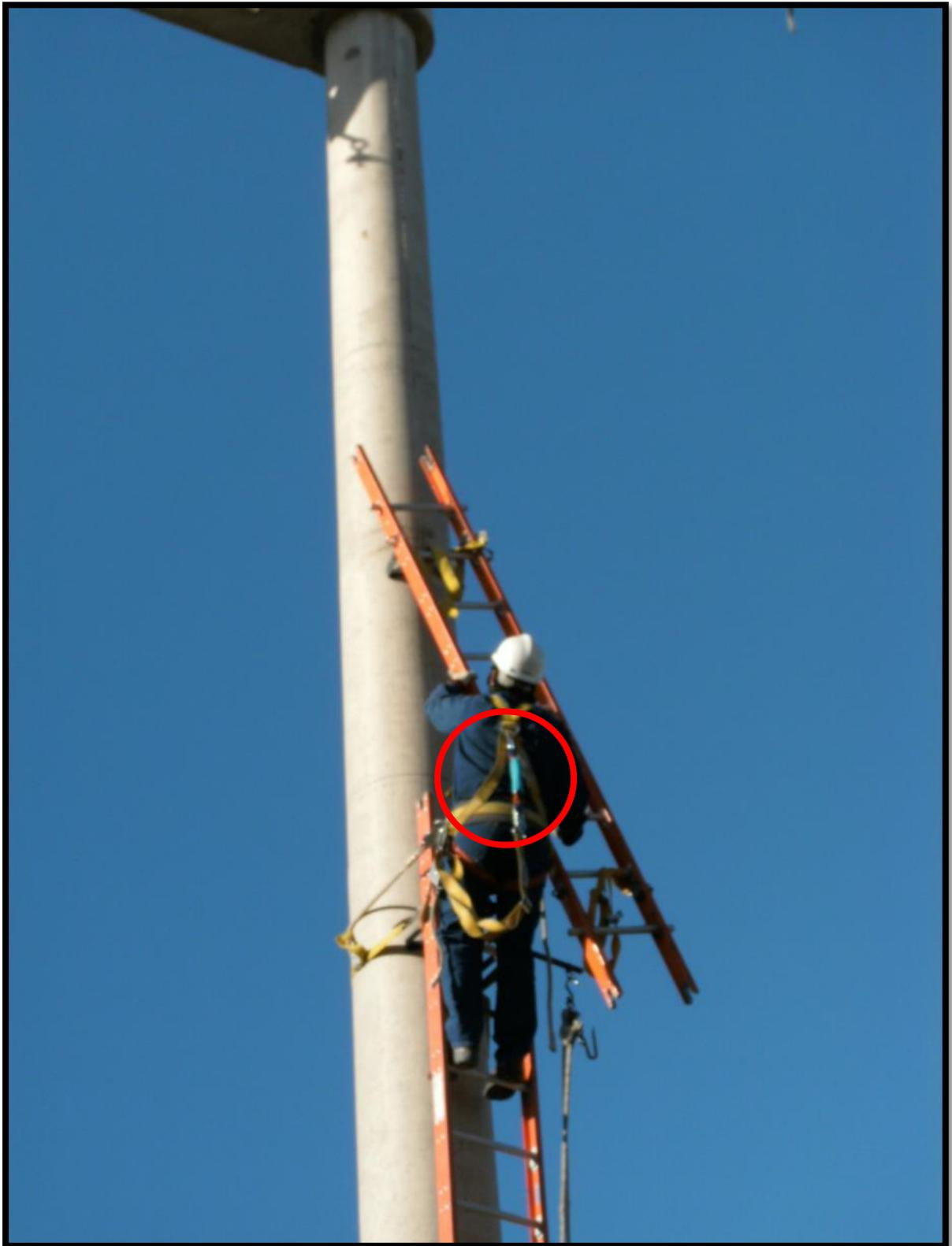
Sistema anticaídas con amortiguador
