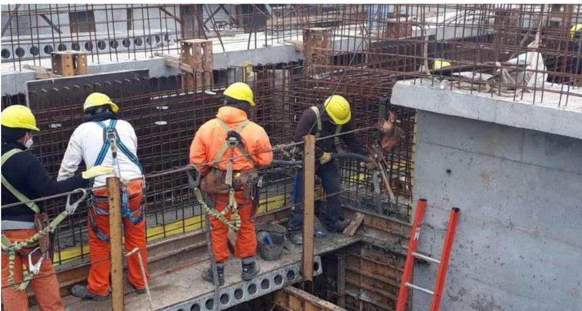
**Imagen 18: Brandas en trabajos de hormigonado**
