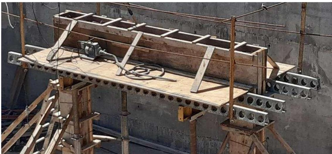
Imagen 24: Vibrador utilizado para la colocación del hormigón
