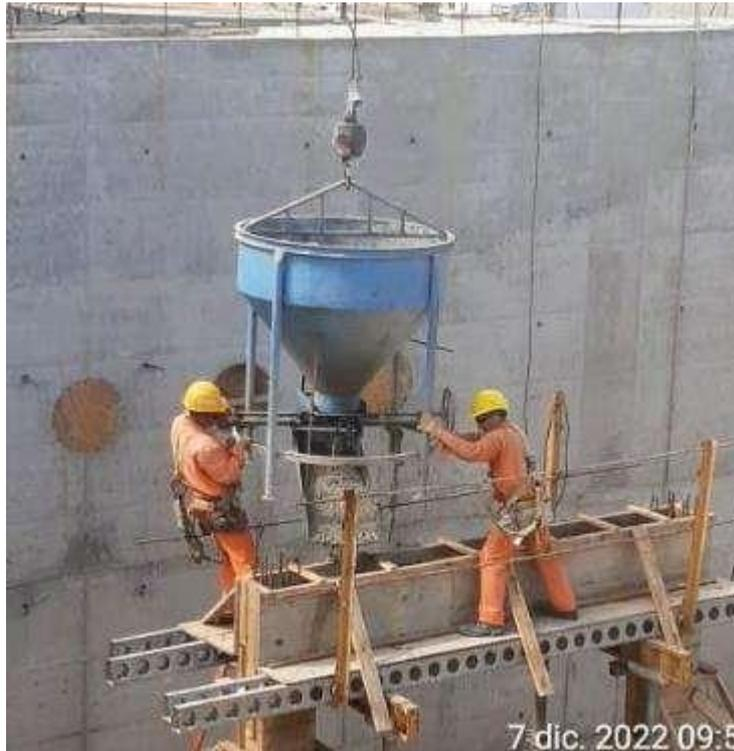
Imagen 13: Manejo de tolva con superficies insuficientes para operarla.
