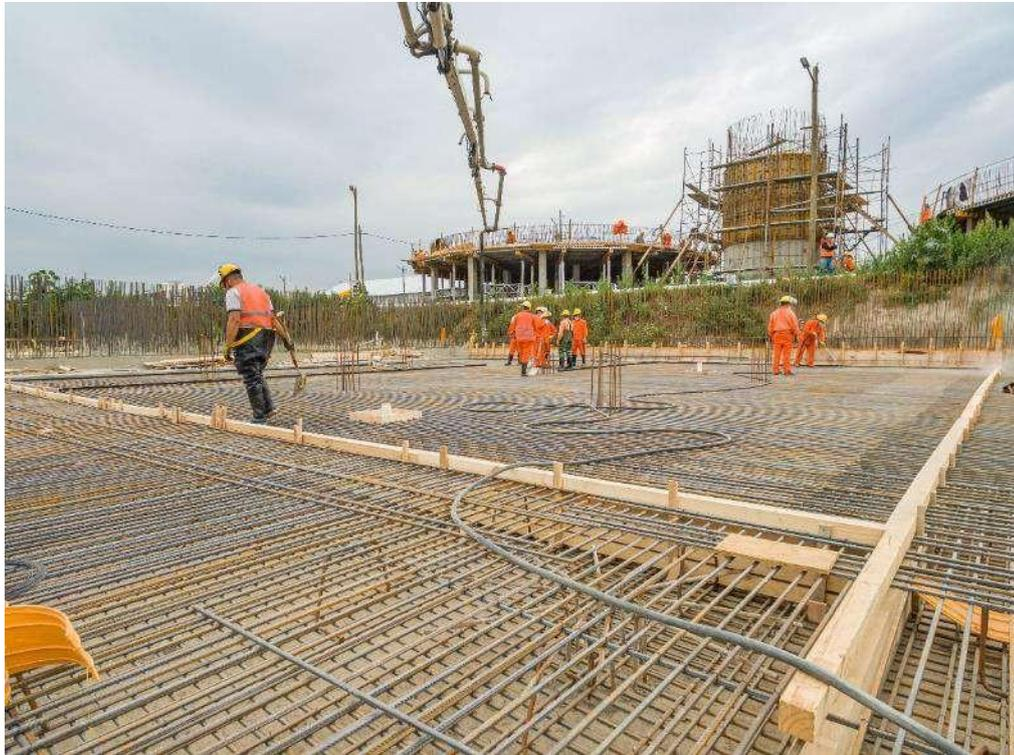
**Imagen 12: Falta de plataformas para pisar armaduras a nivel del piso.**
