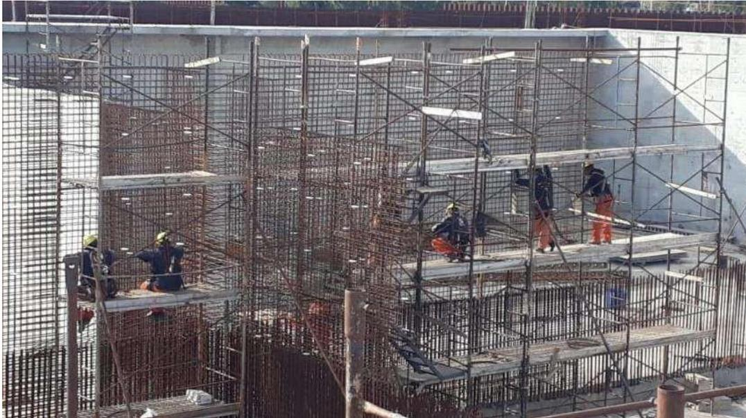
Imagen 2: Trabajo en altura, armaduras confeccionadas “in situ”.
