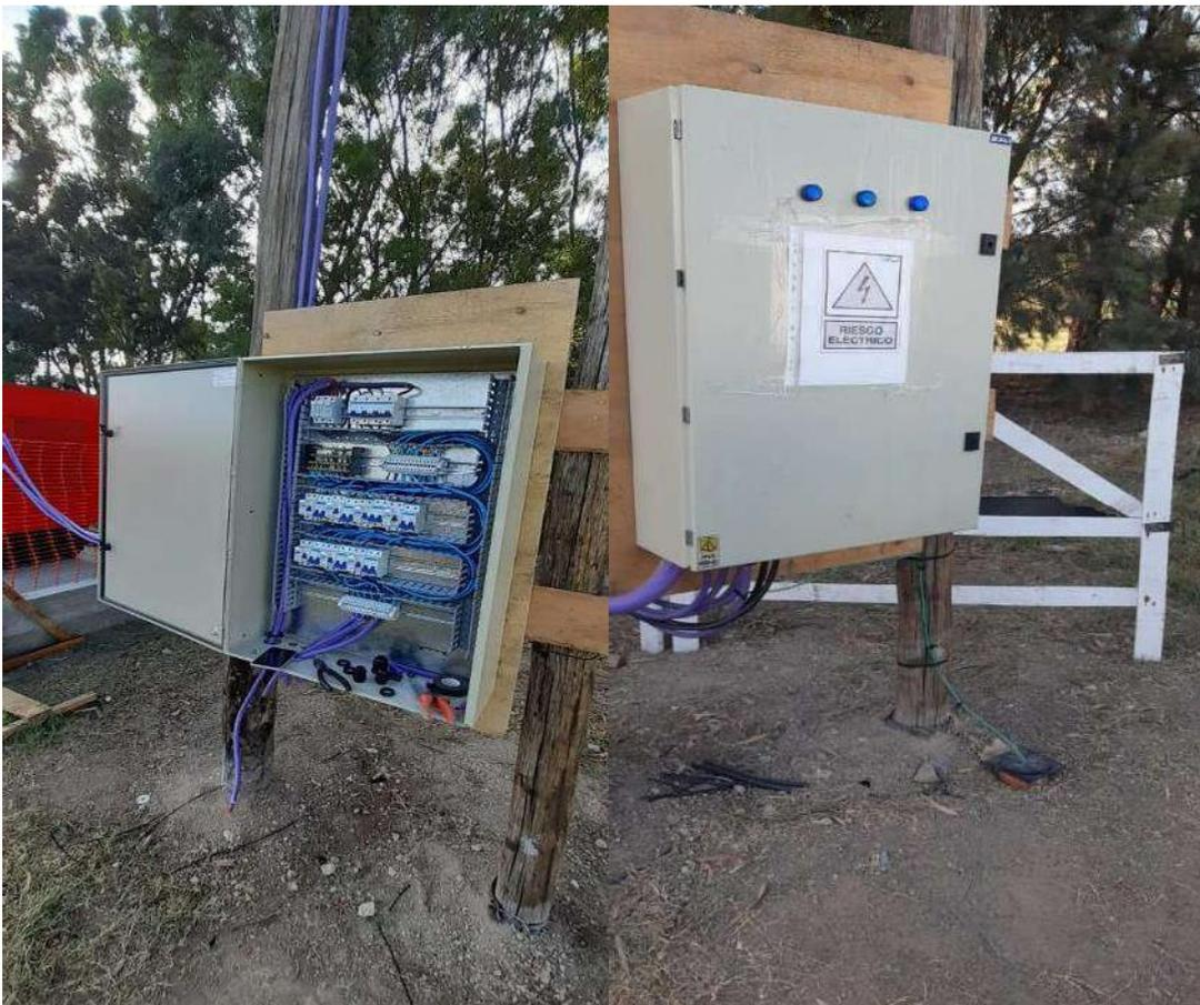
Imagen 21; Instalación de tablero en obra
