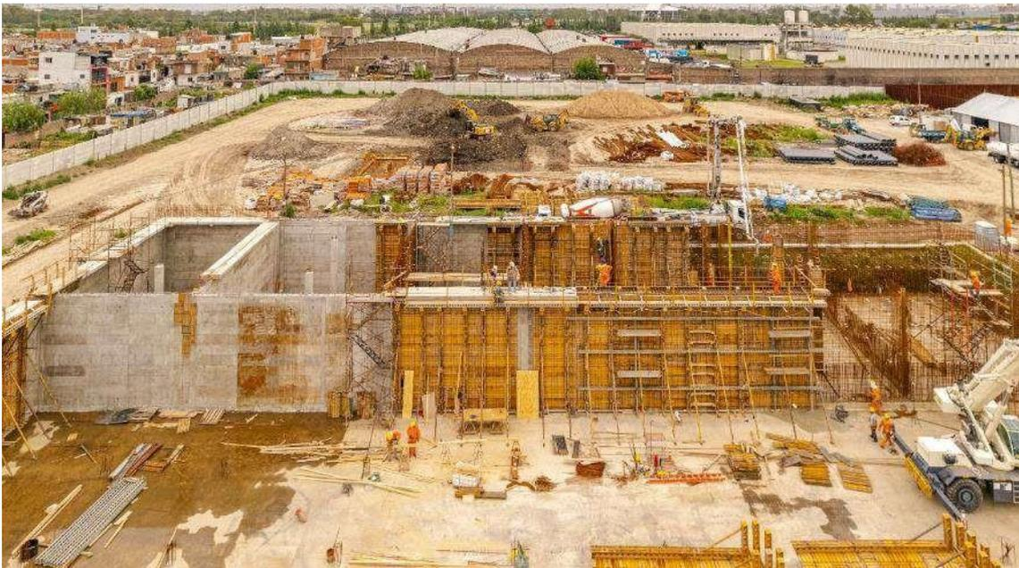
**Imagen 9: Construcción de muros de hormigón armado.**
