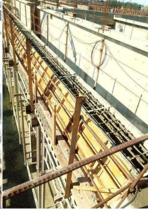
ENCOFRADO CON DAÑOS Y COLPADO DEL HORMIGON
