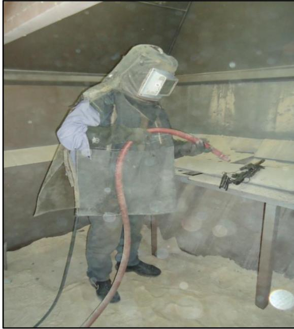
Figura 10. "Posición del operario arenador"
