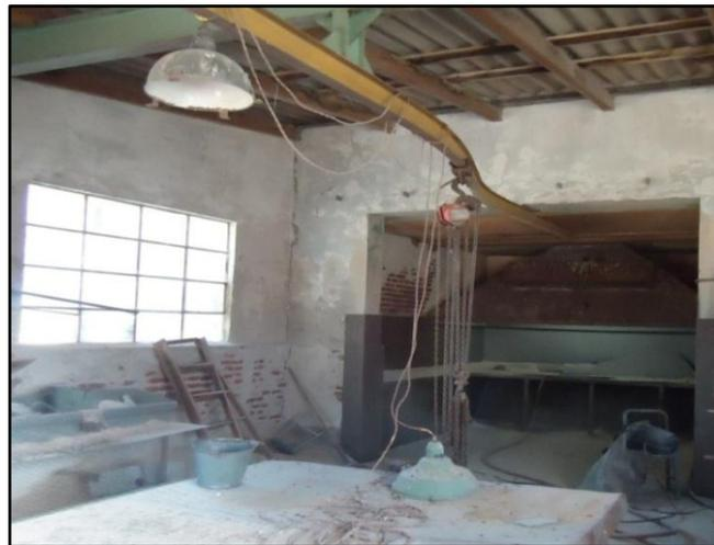
Figura 34. “Luminarias cubiertas de polvo y averiadas”
