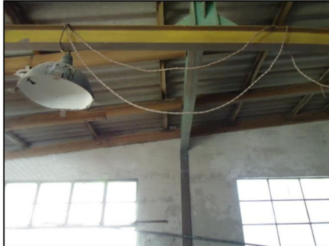
Figura 32. “Ausencia de cobertor de protección en luminaria”
