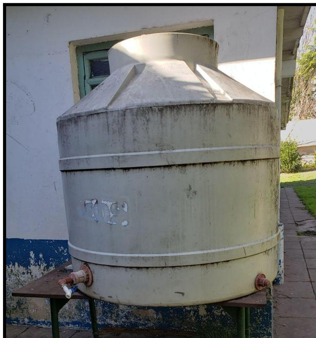
Figura N° 17. Tanque de PVC. Volumen aproximado de 500 litros. Fuente: Victoria Vargas.
