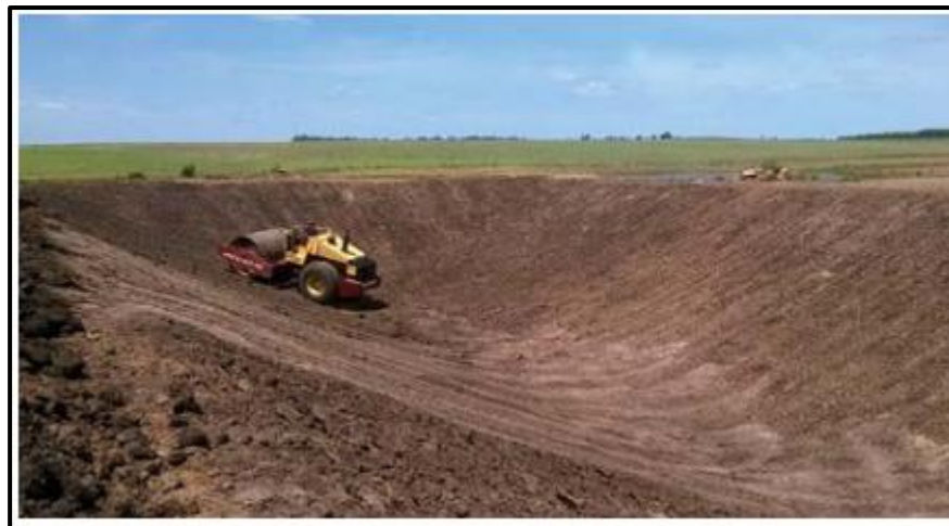
Figura 8. Construcción de laguna Fuente: Correa et al. (2016)
