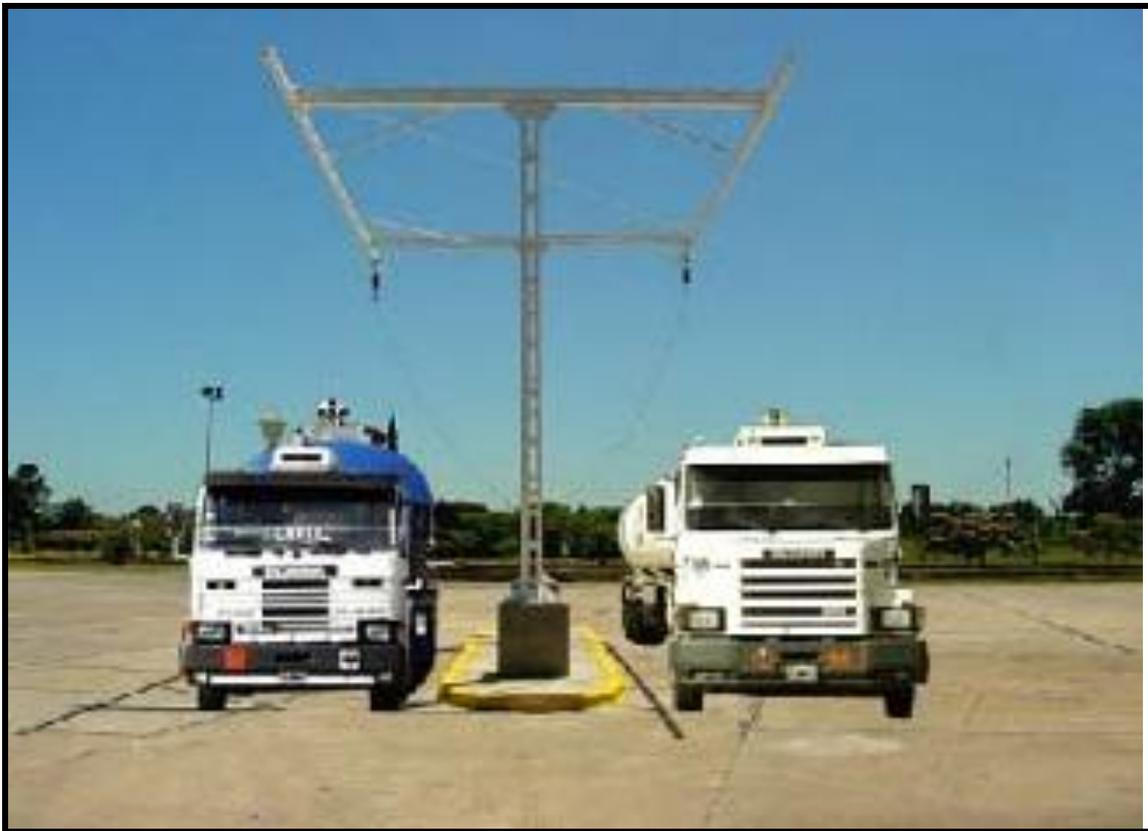
Los rieles o vigas de desplazamiento pueden ser protegidos contra la corrosión mediante la aplicación de pinturas y las frecuencias de control del sistema son más prolongadas y su mantenimiento es notablemente menor. En ambientes pulverulentos puede requerir una limpieza periódica para eliminar las deposiciones de polvo sobre el sector de rodadura del carro.
