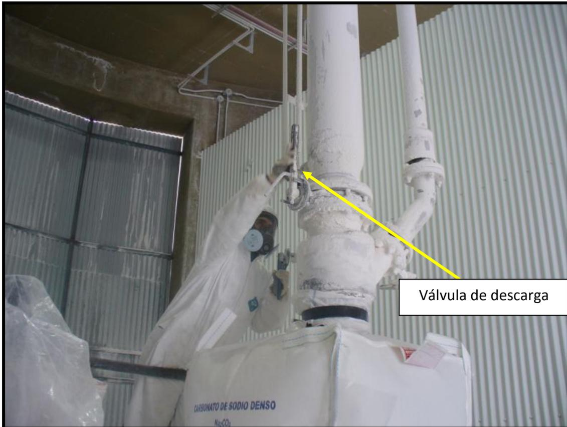
*Operador controlando válvula de descarga.*
