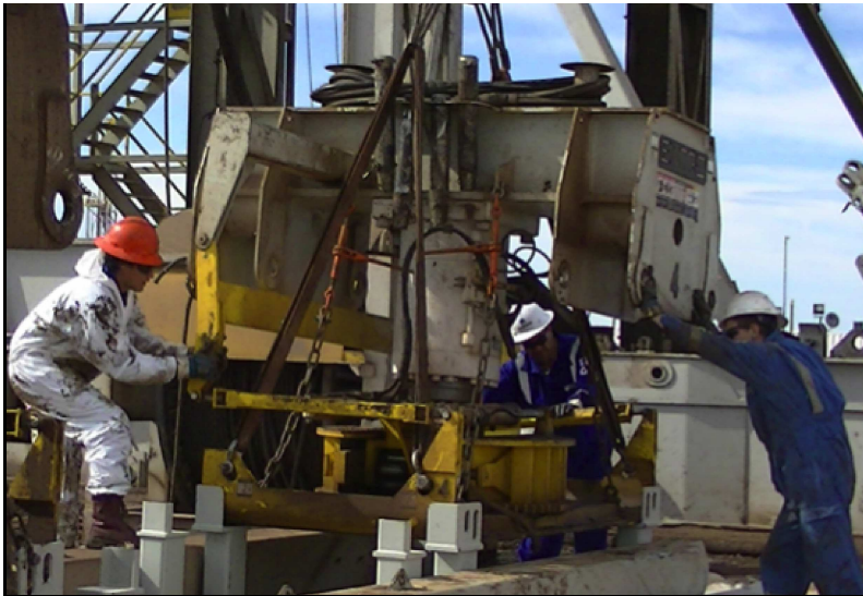
Manipulación de Cargas Pesadas Durante DTM (Desmontaje, Transporte y Montaje)
