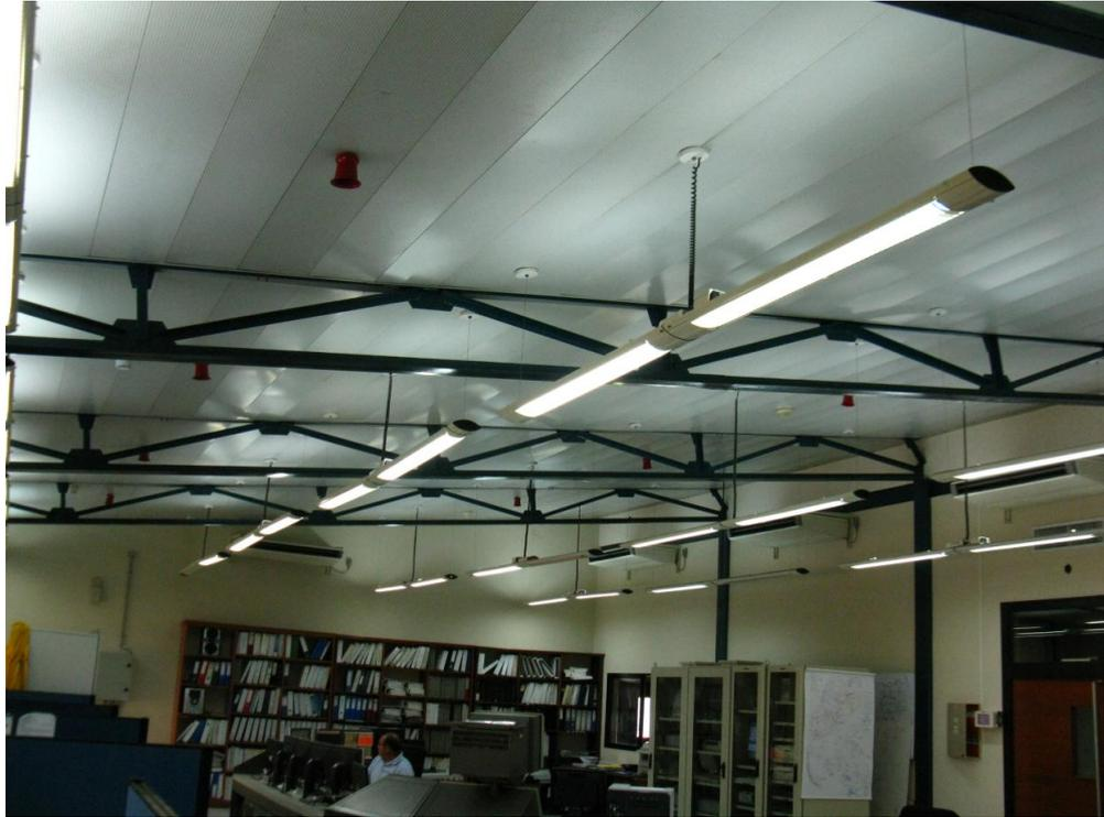
*Fig.7: Sensores de humo ubicados en el techo*
