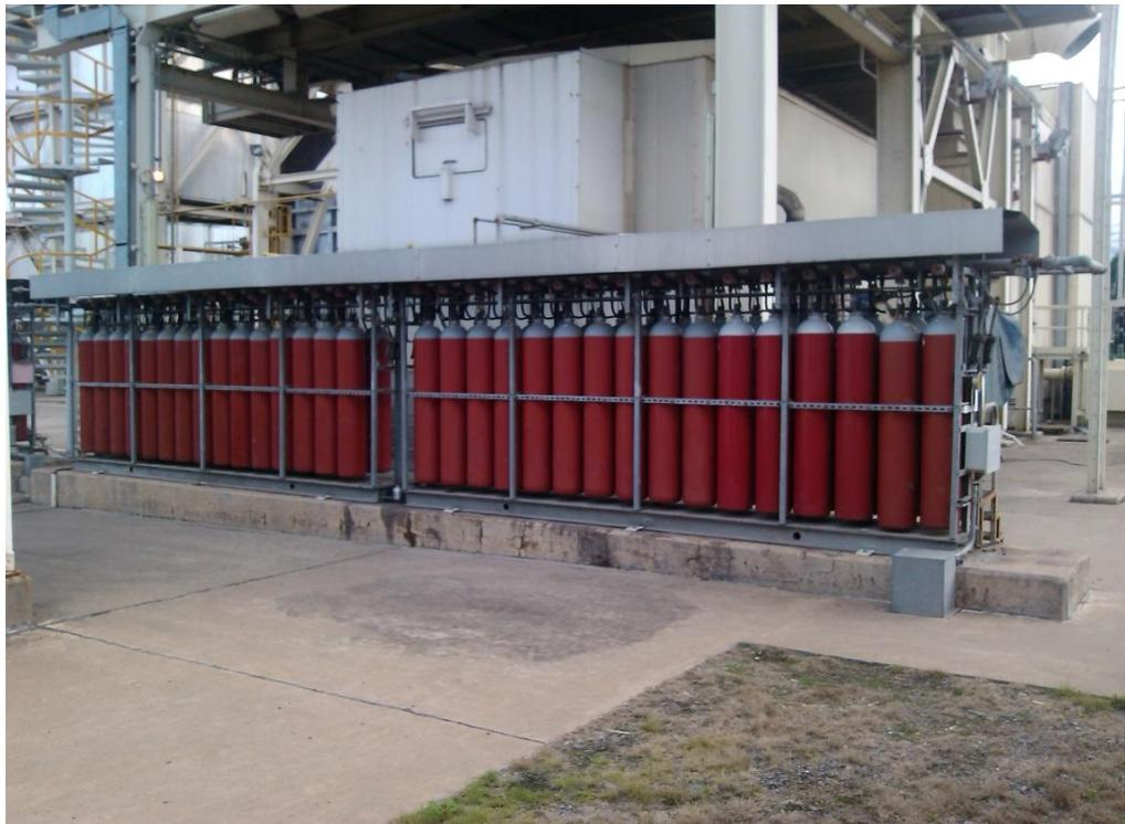
**Fig. 8 Cilindros CO<sub>2</sub> Sistema de extinción**
