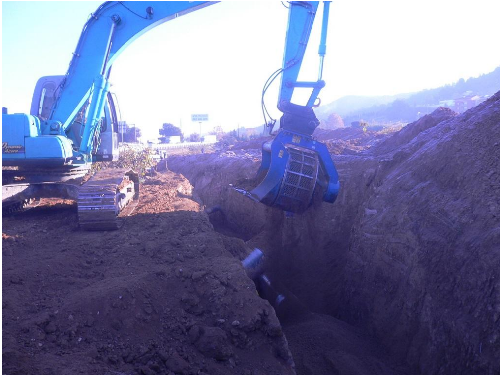
Figura 5.10. Tapada de cañería
