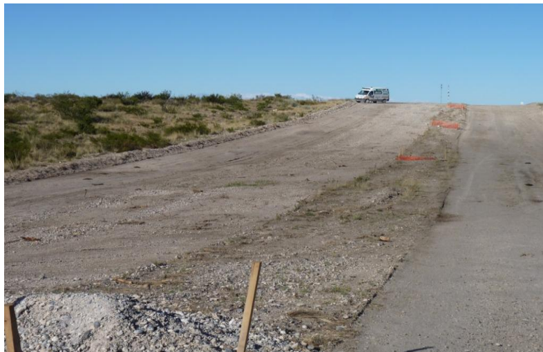
Figura 5.2. Picada desmalezada y nivelada de gasoducto
