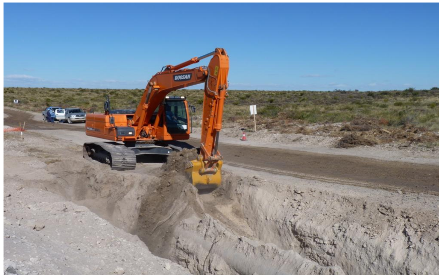
Figura 5.4. Excavadora realizando el zanjeo
