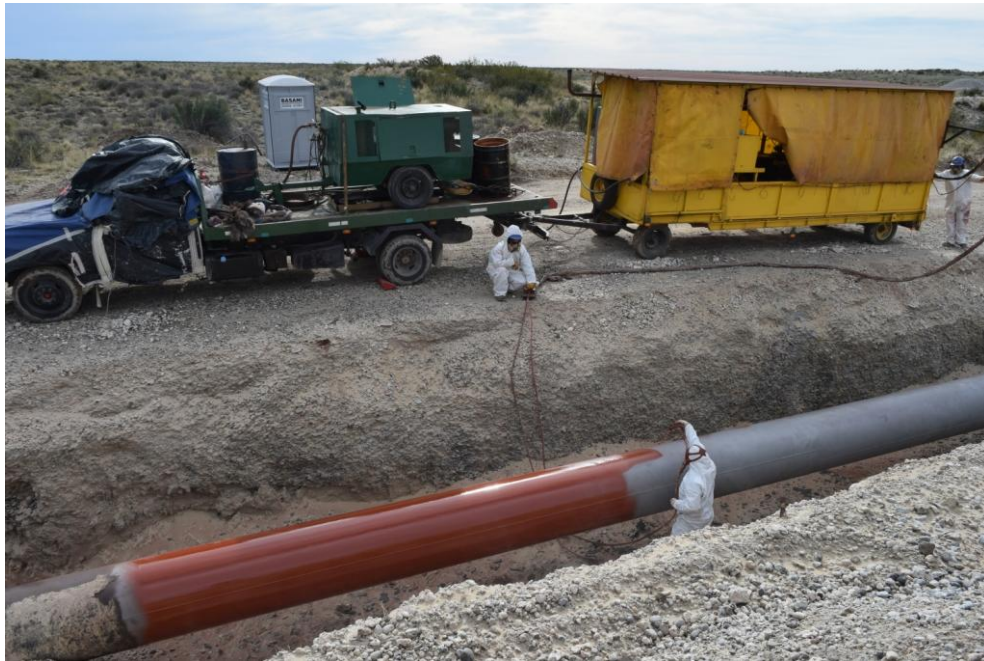
Figura 5.9. Pintado con pintura epoxi
