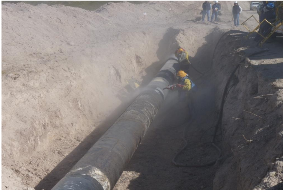
Figura 5.8. Arenado de cañería
