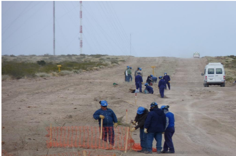
Figura 5.3. Trabajos de sondeos y cateo de cañería
