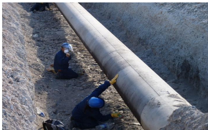
Figura 5.7. Pelado de cañería
