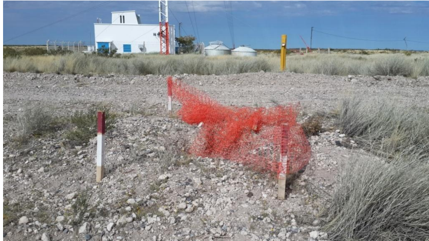
Figura 5.1. Señalización de interferencia (Caño de derivación de alimentación)
