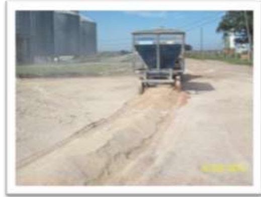
Vaciado de Tolva
