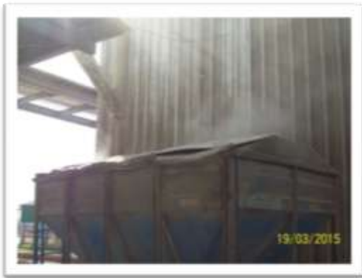
Llenado de Tolva en operación
