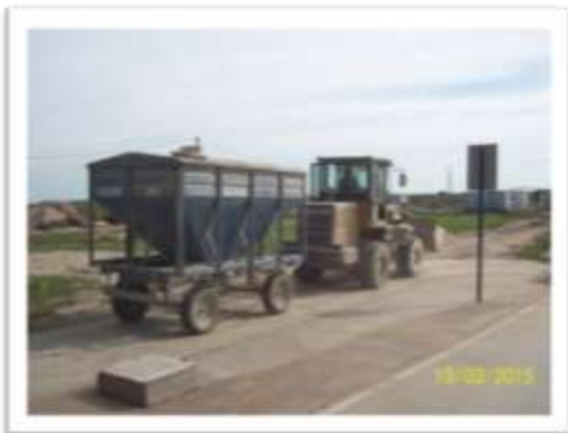
Traslado a lugar de acopio
