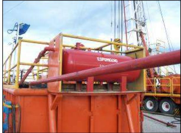
**Espumigeno fijo en pileta de ensayo**
