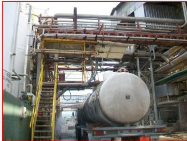
El producto se bombea desde tanques por medio de bombas accionadas por motores eléctricos, y el operador acciona desde el mismo puesto de cargador.
