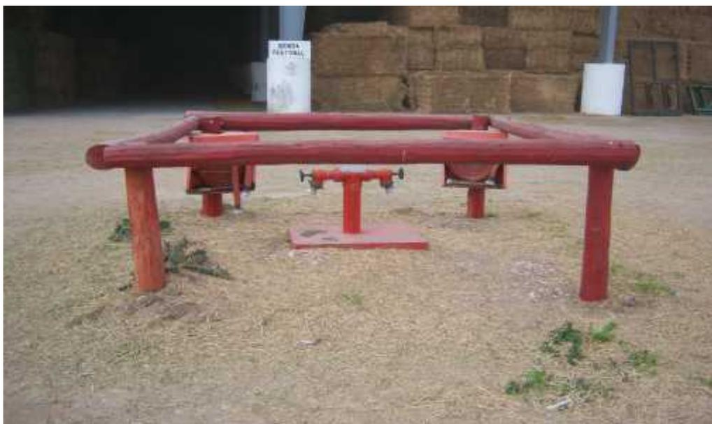
Además, los hidrantes tienen protección perimetral debido al fluido tránsito de vehículos y equipos de planta (camiones, autoelevadores, equipos viales, etc.), de esta forma se protege a los hidrantes ante cualquier choque accidental dejando inutilizables a los mismos ante un caso de emergencia.
