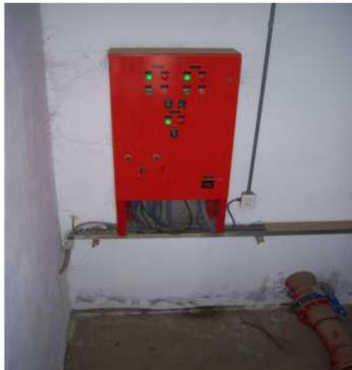
Además, el sistema de lucha contra incendio es comandado por llaves selectoras, dos para cada bomba eléctrica, una para la bomba de auxilio Jockey, un tablero con indicadores Led de “MARCHA”, “PARADA MANUAL” y “FALLA”, todo esto automatizado para la secuencia de arranques y paradas de las bombas mencionadas anteriormente.
