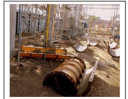
*Acción correctiva:* Evitar trasladar cargas pesadas que impidan la visión y que sean de complicado agarre. Solicitar ayuda para el traslado o utilizar medios mecánicos. Reforzar capacitación sobre Orden y Limpieza. Levantamientos de cargas.
