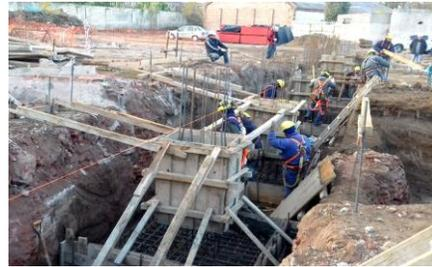
En esta fase para el llenado con hormigón se utilizará camión mixer y balde hormigonero de 2m<sup>3</sup> manipulado por hidrogrúa o con Grúa Torre cuando esté instalada. Luego una vez colocado el hormigón se utilizará regla vibradora para emparejarlo. Para el desencofrado se utilizarán herramientas manuales (barretas, tenazas, cizallas, etc.) retirando las maderas clavadas y cortando alambres. Completado el desarme se volverán a rellenar las excavaciones con la retro hasta nivel de planta baja.
