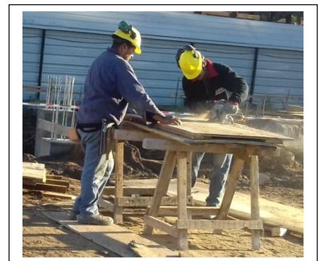
La mayoría de los accidentes se producen cuando la hoja de la sierra queda bloqueada por el material que se está cortando y la máquina es rechazada bruscamente hacia atrás.
