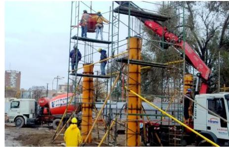
Para esta fase, el sistema de encofrados será modular, con paneles metálicos, adaptables a los tabiques y a las columnas circulares o rectangulares. Para su montaje vertical se elevarán por medio de grúa, colocándose además cuerpos de andamios a una altura máxima de 5,40m debidamente arriostrados y fijos a tierra para seguridad de los trabajadores.
