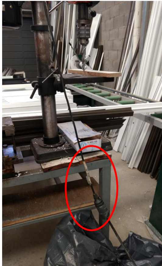
Foto N° 25 conexión cable de electricidad a alargue
