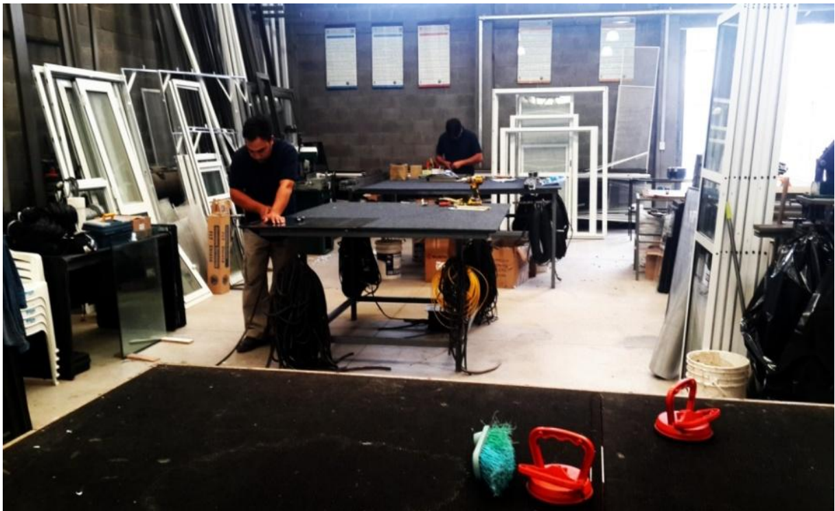
Foto N°10 mesón de armado
