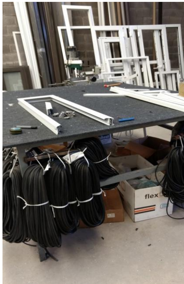
Foto N° 16 mesón de armado
