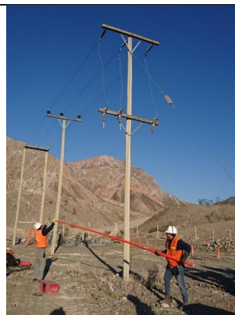
Foto N°78 y 79 retiro de fusibles.
