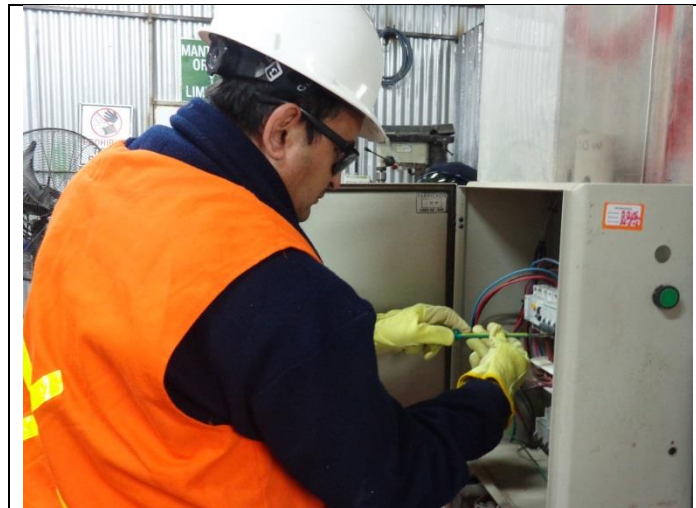
Foto N°9, operario realizando conexión de tablero de potencia sin tensión.
