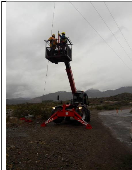
Foto N°11, personal de Mantenimiento Eléctrico realizando trabajos en Altura desde Manipulador.
