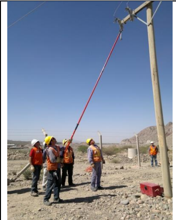
Foto N°64 retiro de Fusibles.
