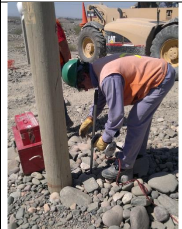
Foto N°67 colocación de jabalina.
