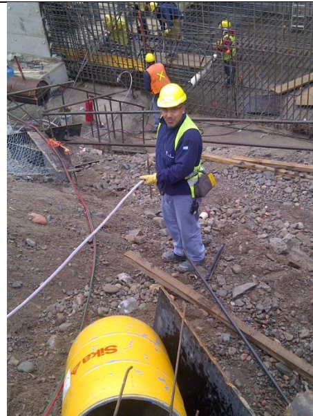
Foto N° 8, trabajos de tendido de conductores.
