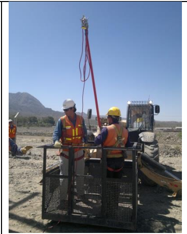
Foto N°70 elevación de personal en canasta.
