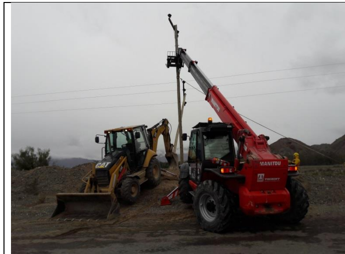
Foto N°10, Personal realizando la colocación de postes con equipos.
