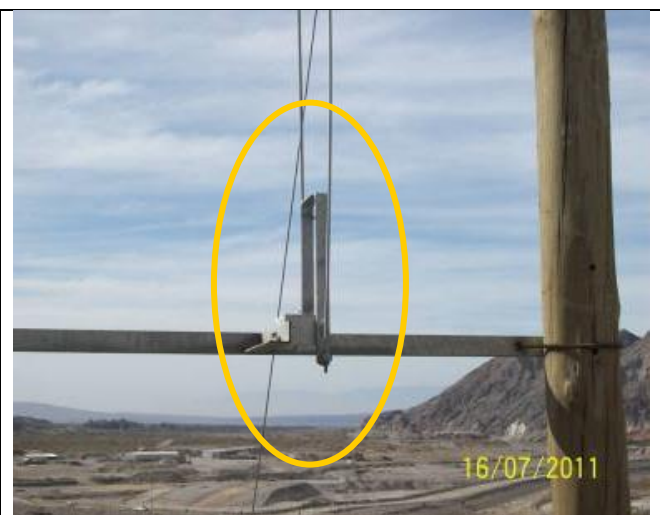
Foto N° 28 Fase S, donde se produce el Arco Eléctrico.
