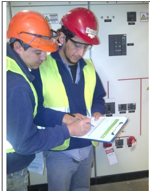
Foto N°61 personal realizando el Permiso de Intervención.
