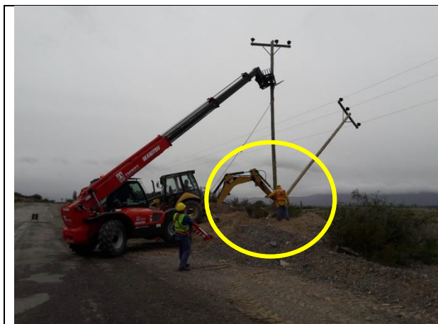
Foto N° 52 Operario realizando señas.
