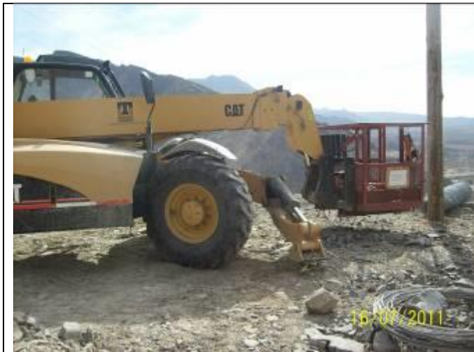
Foto N° 27 Equipo y canasta utilizada para la tarea.
