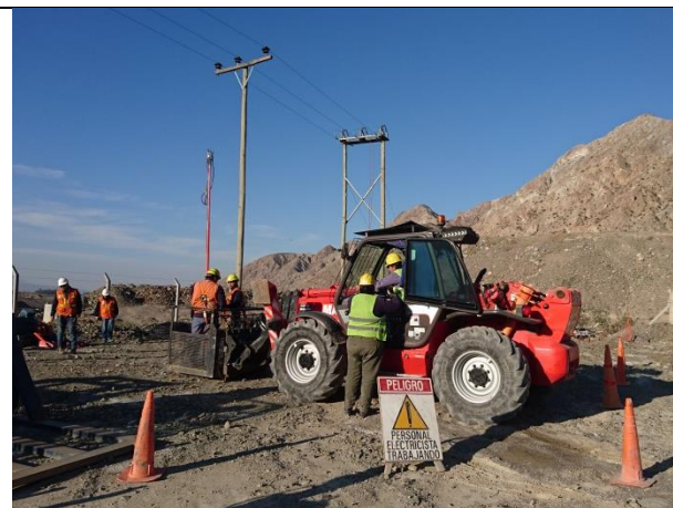
Foto N°77 Firma de operarios en AST.
