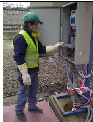
Foto N° 23 Operario realizando etapa de reenergización con EPP Dieléctricos.
