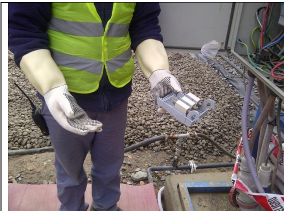
Foto N° 24 Guantes di eléctricos con protección mecánica. Se colocaron guantes moteados encima.
