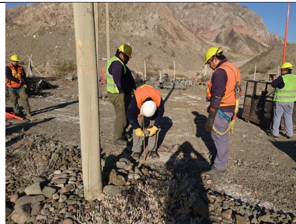
Foto N°74 colocación de jabalina.
