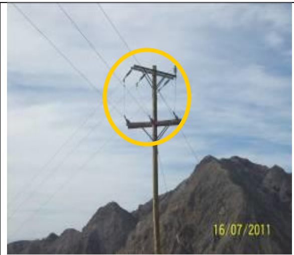
Foto N° 28 Fase S, donde se produce el Arco Eléctrico.
