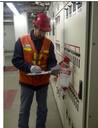
Foto N° 25 Oficial de consignación realizando cheque de consignaciones.
