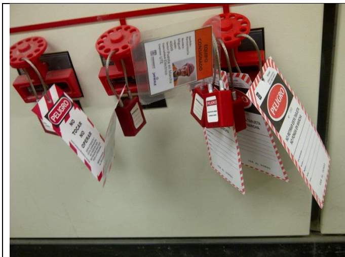
Foto N° 14 bloque y etiquetado (Tarjetas del personal interviniente y del Oficial de Consignación.)
