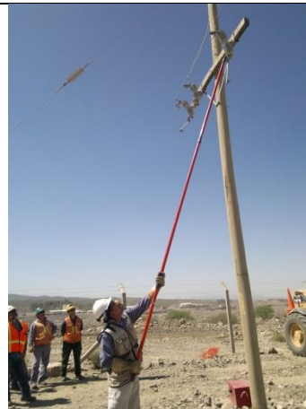
Foto N°66 tesista realizando el retiro de Fusibles.
