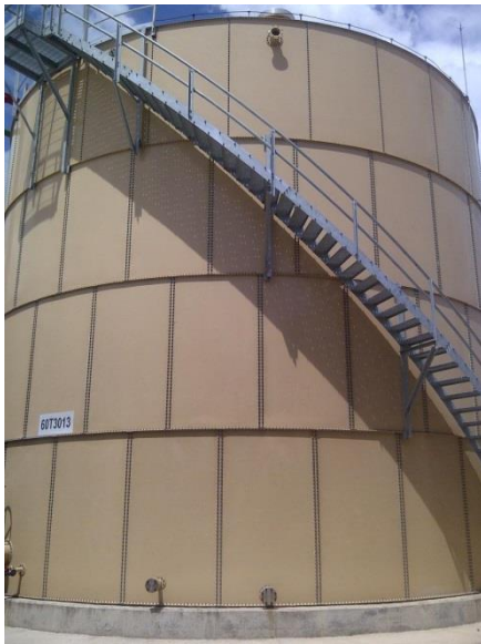
Tanque de agua (1000 m3)
