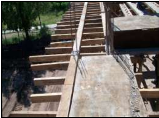
Imagen N°3.9: Colocación de fondo de viga
