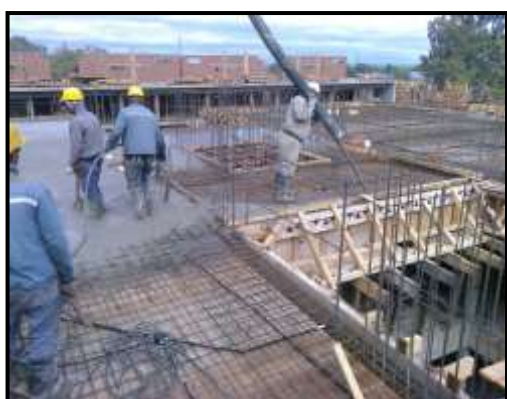
Imagen N° 4.4.14: Colado de hormigón con bomba telescópica
