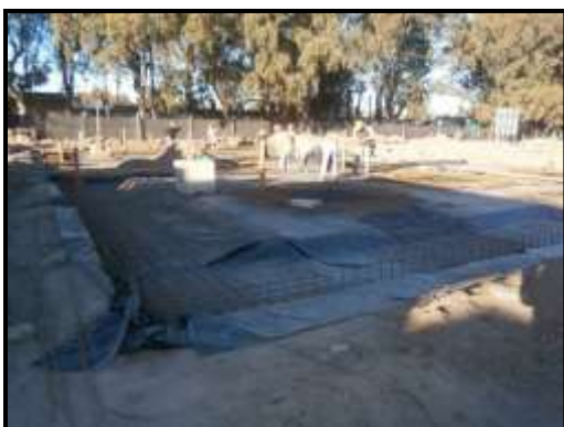
Imagen N° 4.1.3: Fabricación de estructura de hierro para platea
