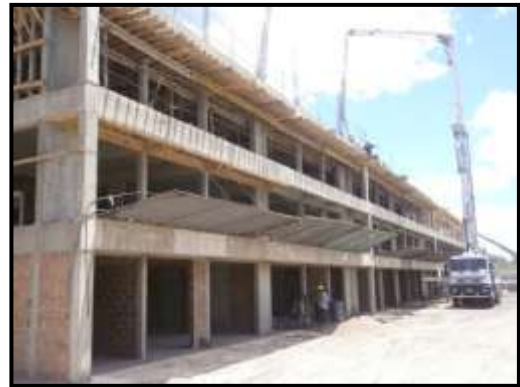
Imagen N° 4.1.2: Colado de hormigón en losa con bomba telescópica
