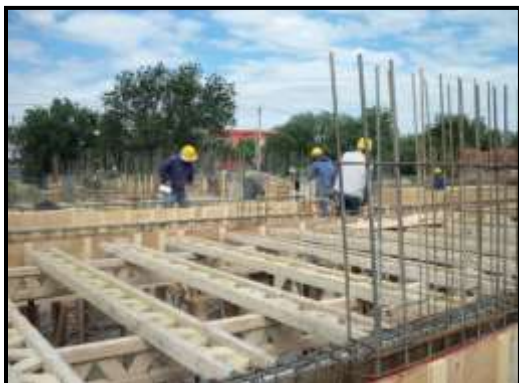
Imagen N°3.11: Colocación de fondo de losa
