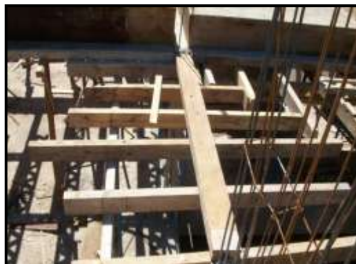
Imagen N°3.12.: Colocación de fondo de losa y fondo de viga
