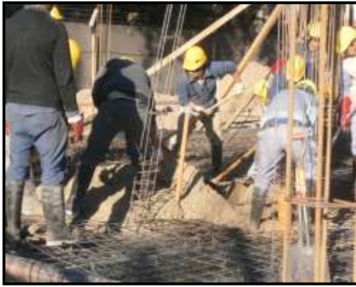
Imagen N° 4.4.16: Esparcido de hormigón
