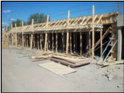
Imagen N°3.1: Proceso de encofrado de losa finalizado
