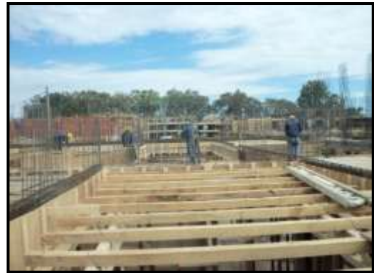
Imagen N°3.10: Colocación de fondo de viga y fondo de losa
