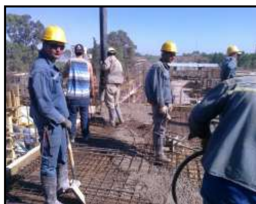
Imagen N° 4.4.15: Colado de hormigón con bomba telescópica
