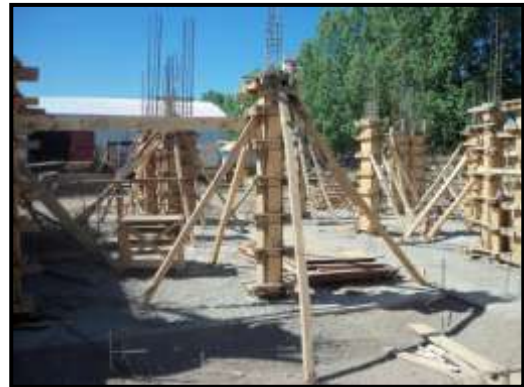
Imagen N° 3.2: Proceso de encofrado de columnas finalizado
