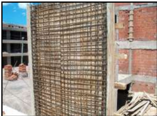
Imagen N° 3.7: Encofrado de columnas
