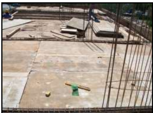
Imagen N°3.13: Colocación de tapa de losas
