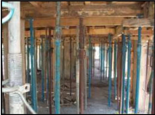
Imagen N°3.15: Apuntalamiento de losa con puntales metálicos
