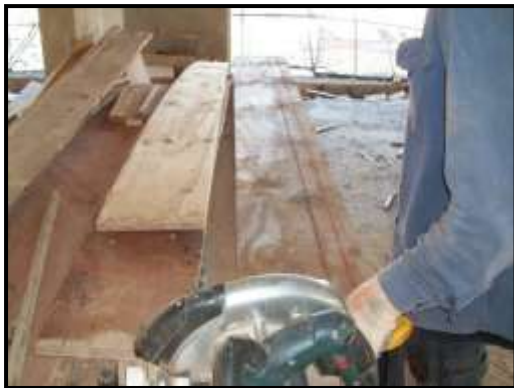
Imagen N° 3.5: Corte de moldes
