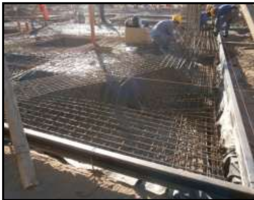
Imagen N° 4.4.12: Instalación de refuerzos en estructura para plateas
