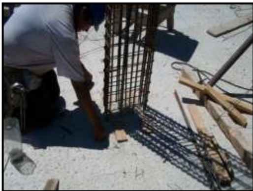
Imagen N°3.3: Replanteo de columnas
