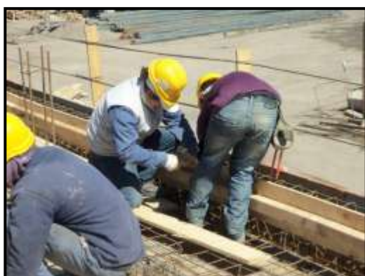
Imagen N° 4.3.4: Colocación de laterales de viga
