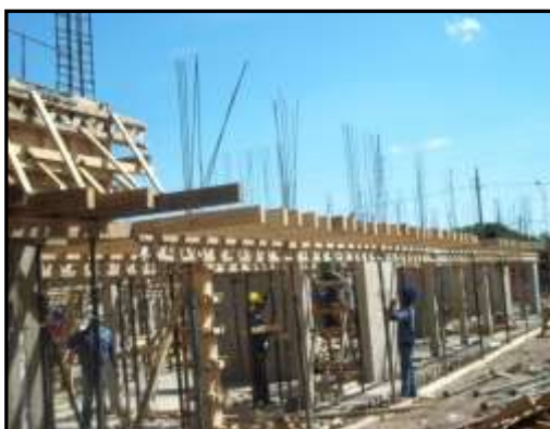
Imagen N° 4.4.2: Colocación de fondo de losa y apuntalamiento.
