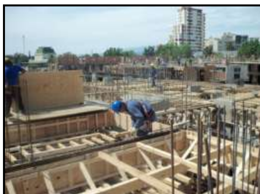
Imagen N° 4.3.5: Colocación de laterales de viga.
