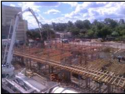
Imagen N° 4.1.1: Colado de hormigón en columnas con bomba telescópica
