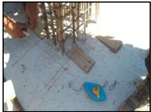
Imagen N° 3.4: Replanteo de columnas
