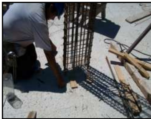
Imagen N° 4.4.7: Replanteo de columnas
