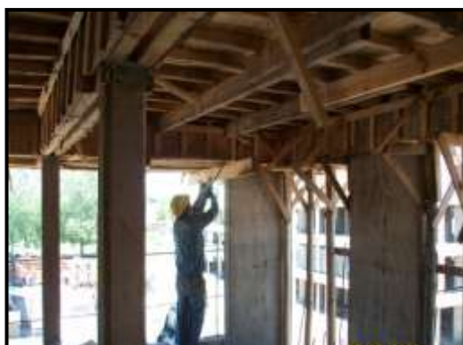
Imagen N° 4.3.6: Desencofrado de losas
