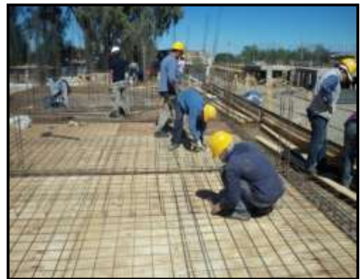
Imagen N° 4.4.13: Instalación de refuerzos sobre losa
