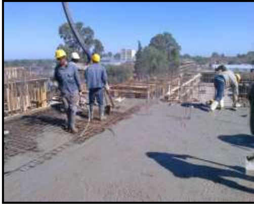
Imagen N° 4.4.18: Terminación de hormigón
