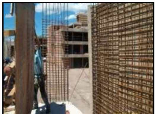
Imagen N°3.8.: Encofrado de columnas
