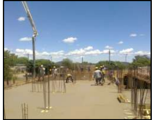
Imagen N° 4.4.19: Terminación de hormigón
