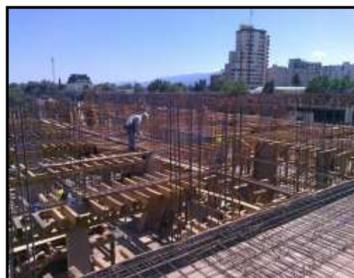
Imagen N° 4.4.11: Instalación de viga
