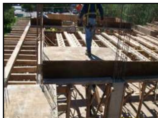
Imagen N° 3.14: Colocación de tapa de losas
