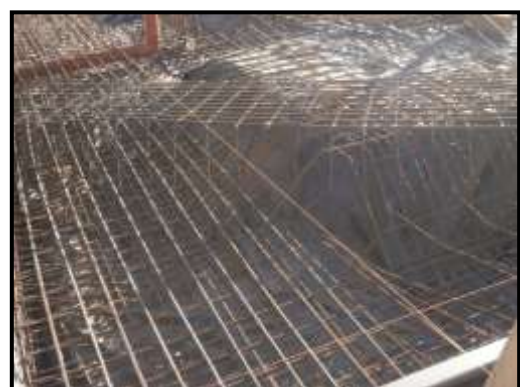
Imagen N° 4.1.4: Estructura de hierro para platea
