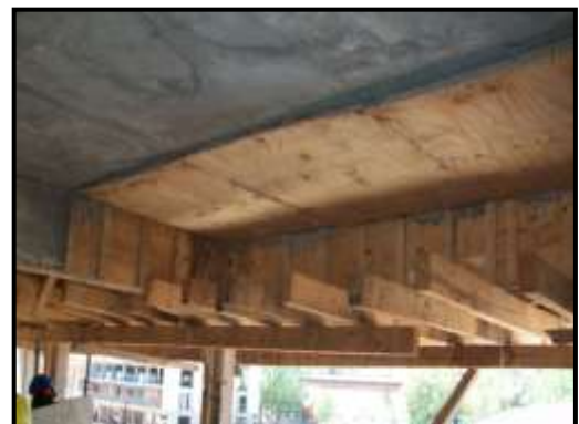
Imagen N°3.18: Proceso de desencofrado
