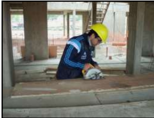
Imagen N° 4.4.1: Corte de moldes con cierra circular de mano
