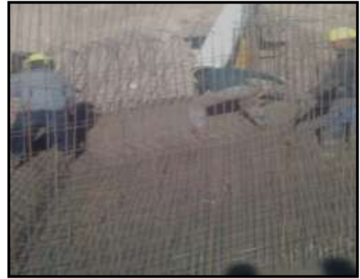
Imagen N° 4.4.17: Esparcido de hormigón
