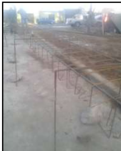
Imagen N°4.4.9: Viga en proceso de ensamblado
