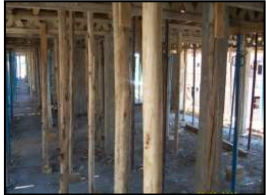
Imagen N° 3.16: Apuntalamiento de losa con puntales de madera
