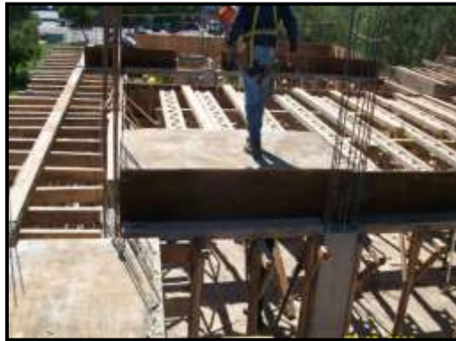
Imagen N° 4.4.3: Colocación de tapa de losa.
