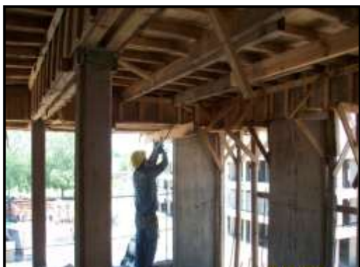
Imagen N° 3.17: Desencofrado de losa
