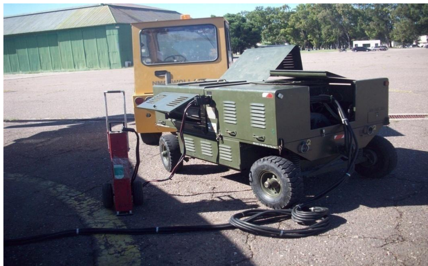
Foto N° 22 - Grupo electrógeno con su manguerote y batería externa sin conexión a tierra al aeronave - Fuente propia.
