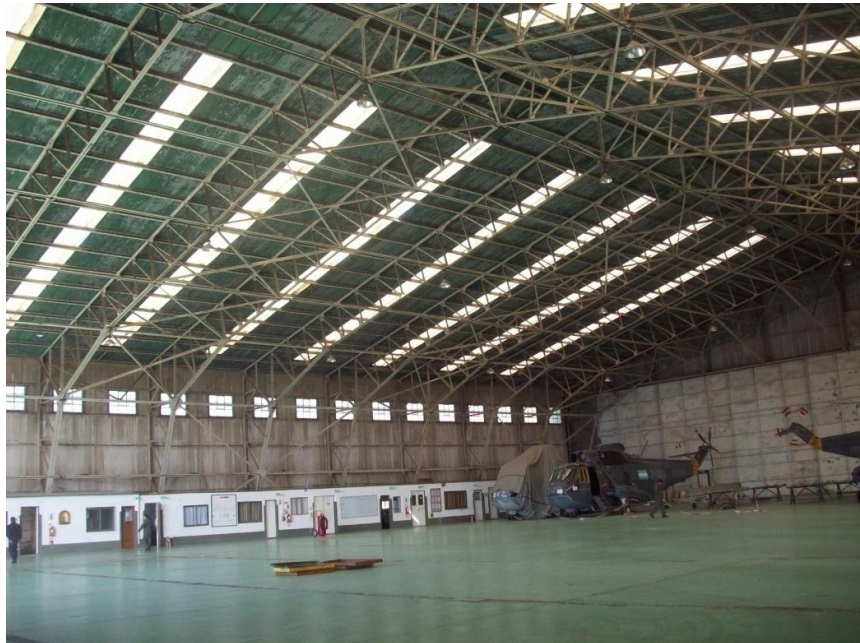
Foto N° 8- Vista del hangar y oficinas administrativas- Fuente Propia
