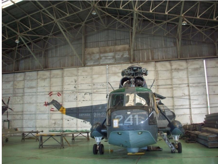
Foto N° 10 – Estructura interna del Hangar 2- Fuente propia
