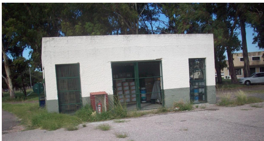
Foto N° 33- Depósito transitorio de Residuos Peligrosos- Fuente propia.
