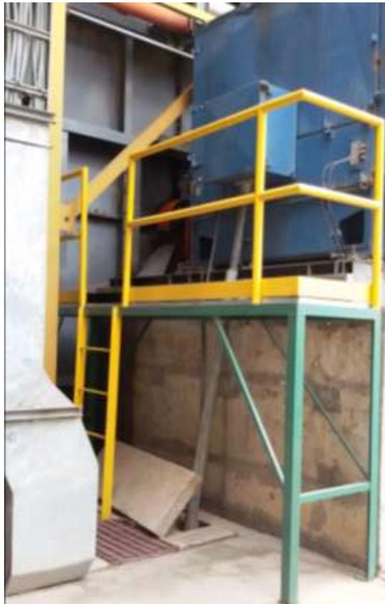
Figura N° 8 Colocación de barandas en Plataforma de trabajo
