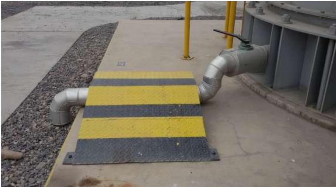
Figura N° 11 Colocación de rampa de paso
