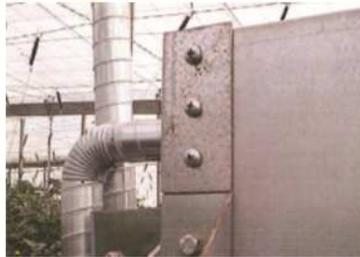
Foto 2. Detalle de la perfilería saliente de la parte superior de la tolva, donde se produjo el enganche del anillo del trabajador.
