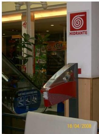
*Sistema de hidrantes:* dispone de hidrantes con válvula tipo teatro de  $1\frac{1}{2}$ " de 3 diámetro, mangueras sintéticas PT 1kp diámetro  $1\frac{1}{2}$ " largo 25 mts con uniones, lanzas chorro pleno-niebla
