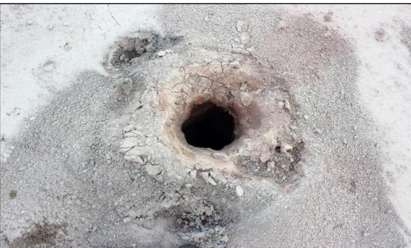
*Imagen 3:* Perforación terminada y lista para ser llenada con material explosivo.
