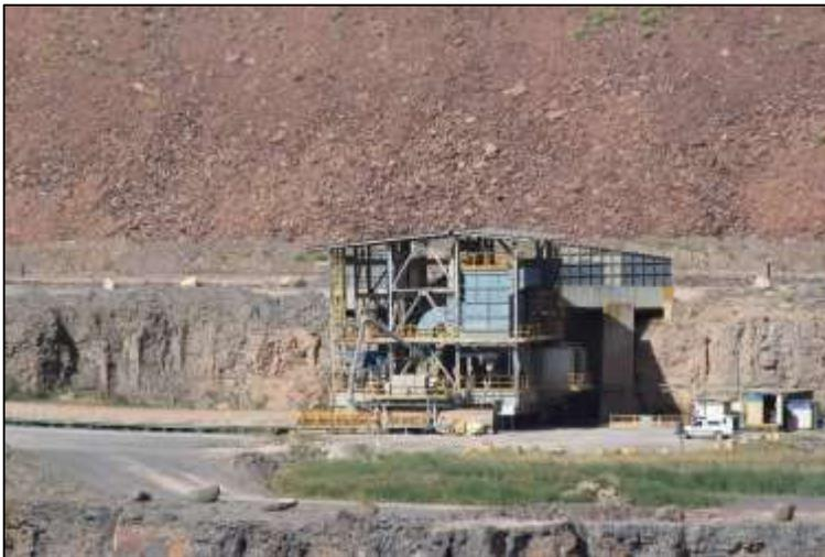
Rompedora primaria. Esta formidable máquina revive por medio de dos tolvas la descarga de piedra caliza realizada por los equipos Caterpillar 773D y Komatsu HD605. Mediante una serie de rodillos muele la piedra hasta una medida de 20 Cm de diámetro aprox.
