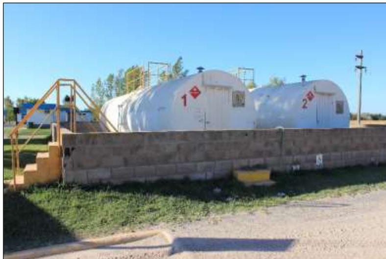
*Imagen 1 – Tanques y pileta de contención*
