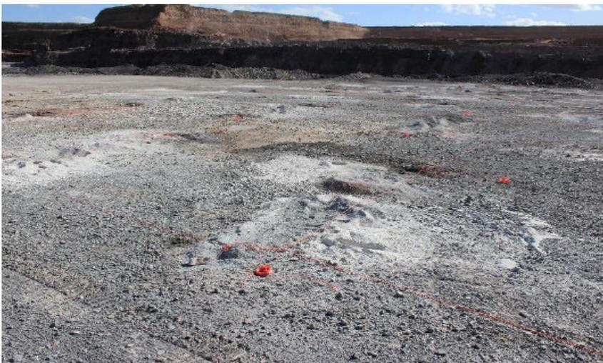
*Imagen 3:* Sector de marcado de grillas. En este caso ya se realizaron las perforaciones y se completaron con material explosivo. Los cables naranjas son los detonadores.
