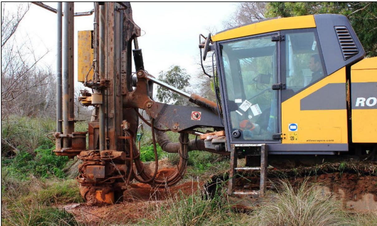
*Imagen 1:* Perforadora realizando cateo dentro de un monte.
