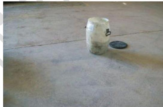
10) Estado del piso luego del retiro de material absorbente, sin rastros visibles de hidrocarburo.
