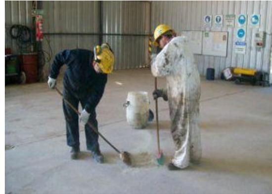
3) Una vez contenido se completa material absorbente en el interior del derrame. Se recoge el excedente con un cepillo hacia el interior del derrame
