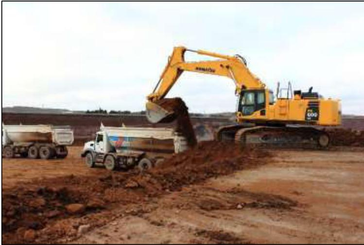
En esta imagen se puede observar como la retroexcavadora Komatsu PC600 toma material terroso del sector de destape y lo deposita en la caja del camión Mack Granite. Se observa también la presencia de un segundo camión a la espera para ser cargado.
