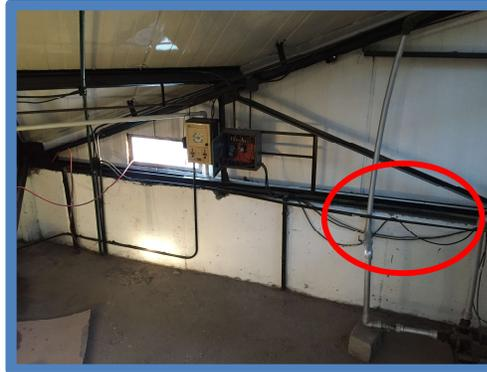
Para solucionar este inconveniente debemos contener los cableados por dentro de cañerías o por medio de cable canal, esto tiene un costo de \$ 50 a 100 x metro (Pesos Argentinos).
