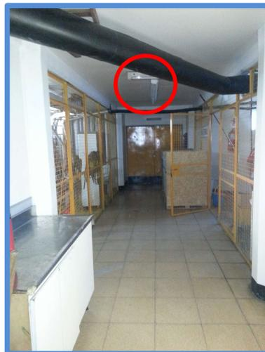
Una solución económica es la colocación de protección anticaída de luminaria tipo rejilla la cual permite el paso de la luz teniendo un costo aproximado de \$ 600 (pesos Argentinos).
