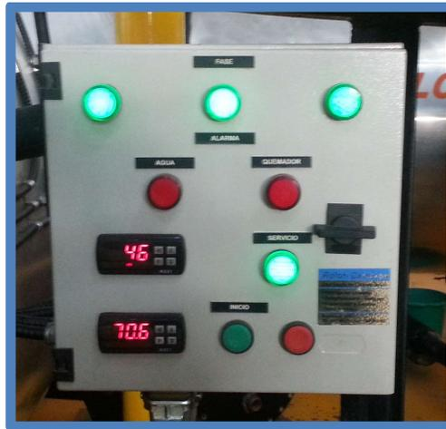
**Alarma de temperatura excesiva:** esta luz se enciende cuando la temperatura del agua de la caldera es excesiva, para resetear la caldera se deberá cortar la alimentación y volver a conectarla, esto debe presionar el botón del programador ubicado en el tablero del quemador.
