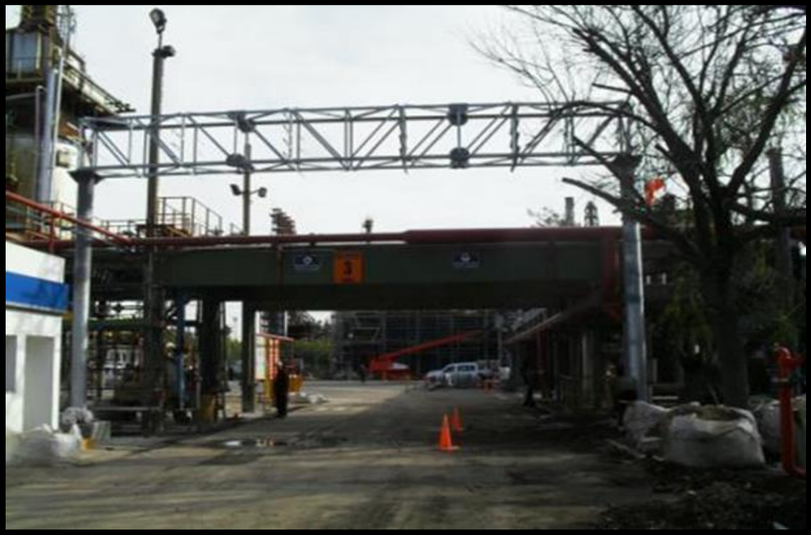
- Montaje de estructura metálica para cruce de calle.
