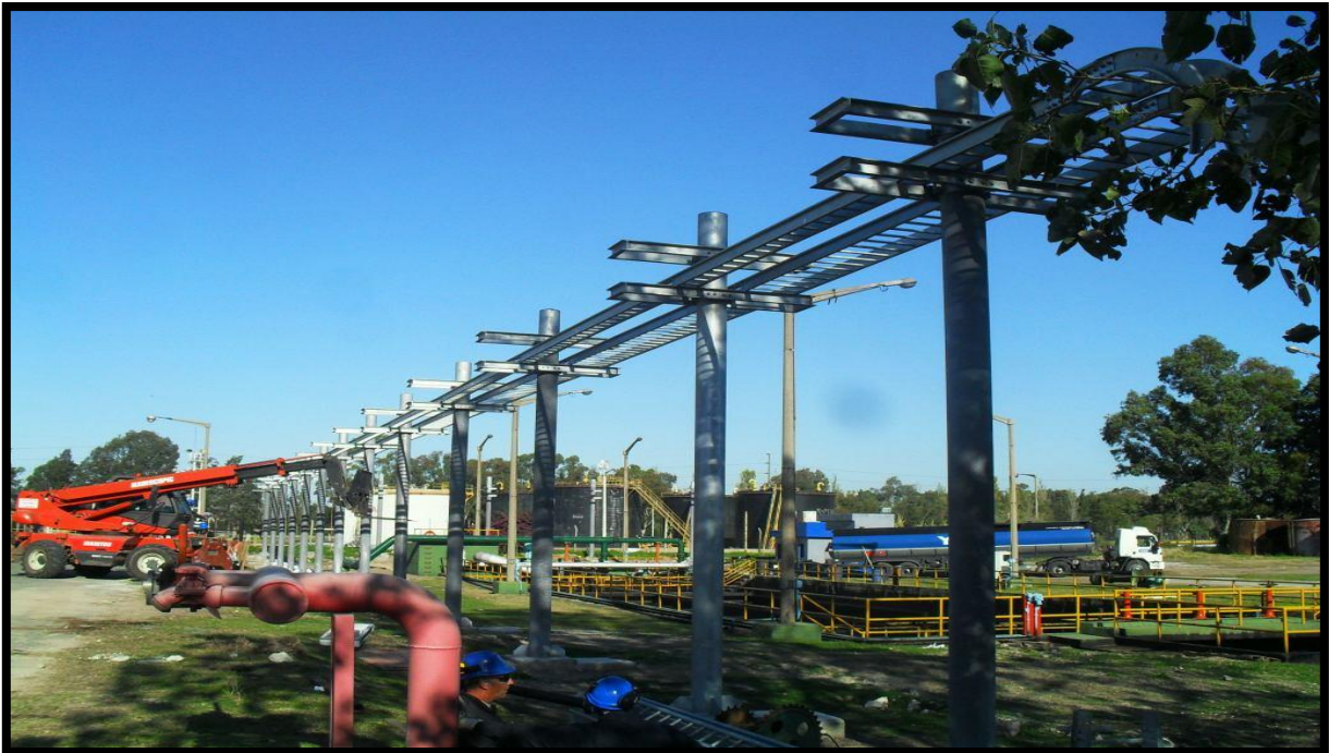
- Montaje de bandejas porta cables con apoyo de equipo JLG.
