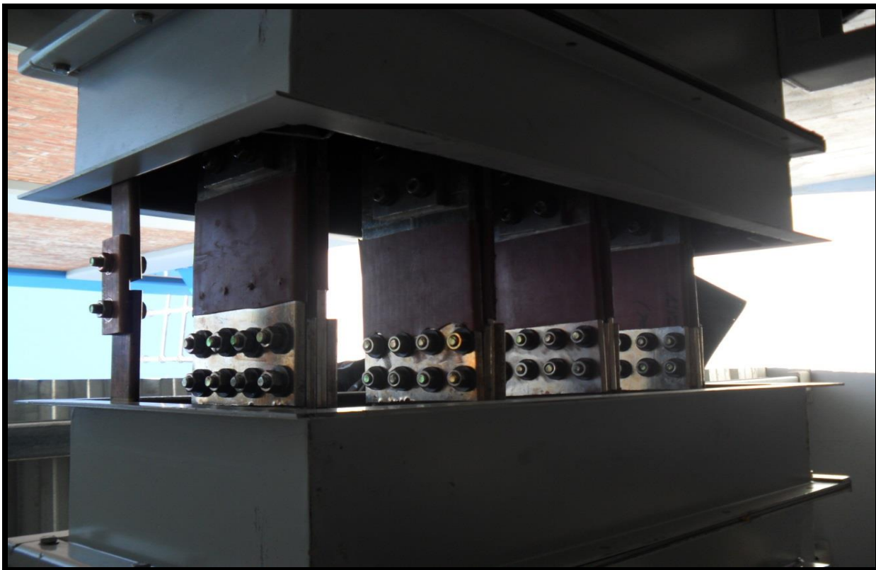
- Ajuste y Torque de barras conductoras MT.
