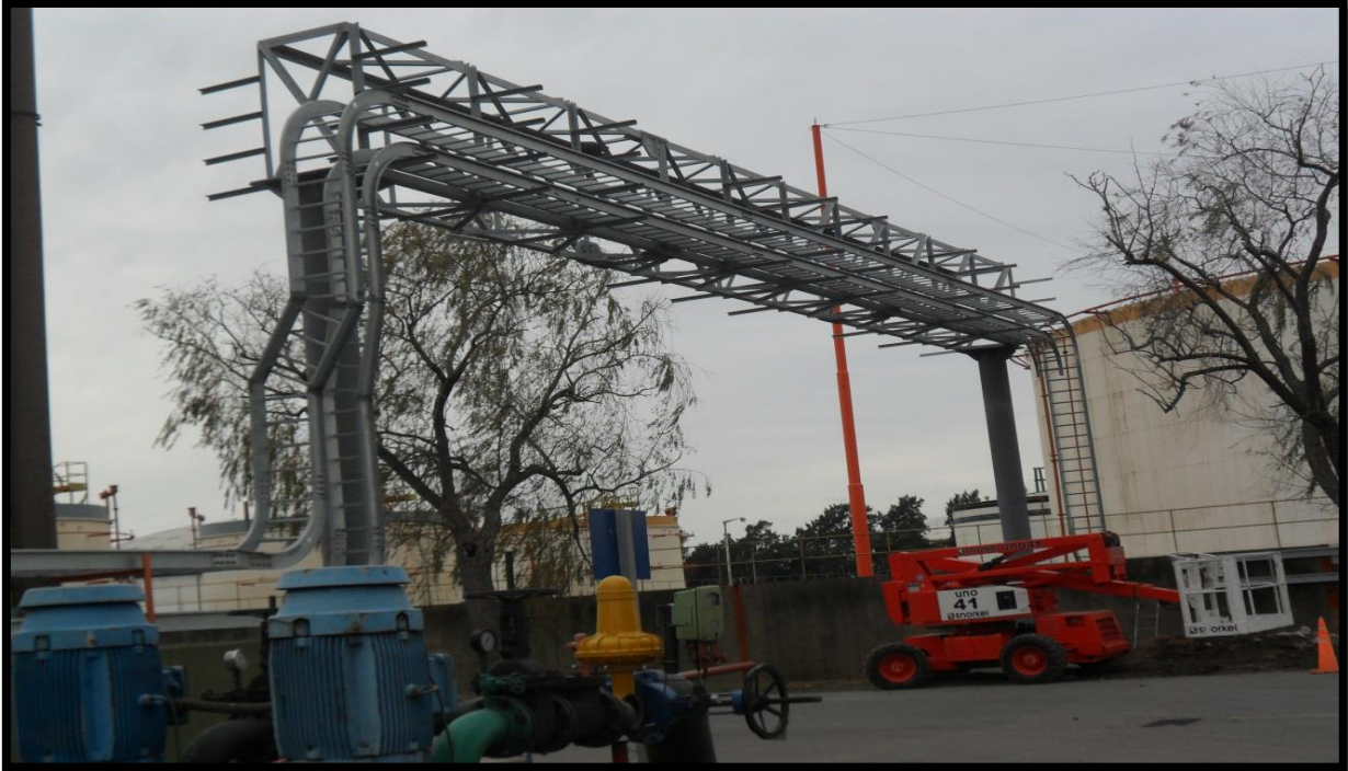
- Montaje de estructura metálica (cruce de calle) para soporte de bandejas y cables.
