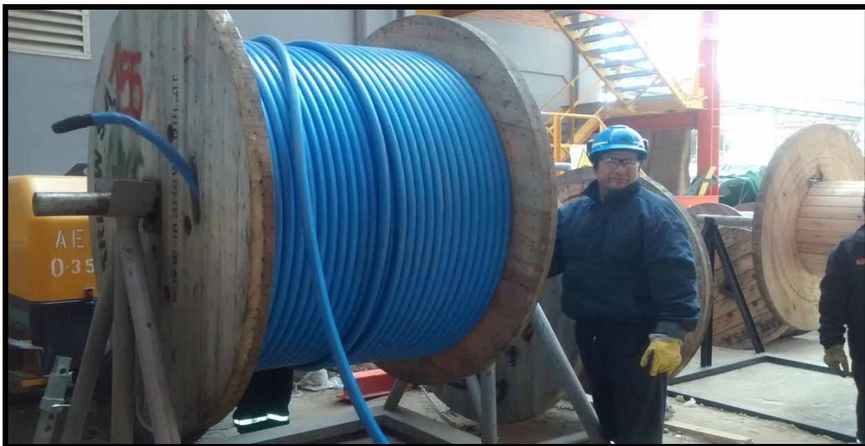
Tendidos de cables de potencia.
