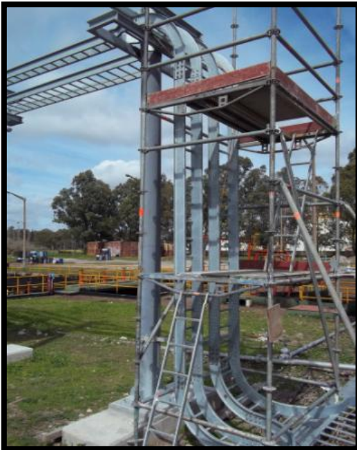
- Andamio para realizar acometida de bandejas a pileta 12 y completamiento de soporteria.
