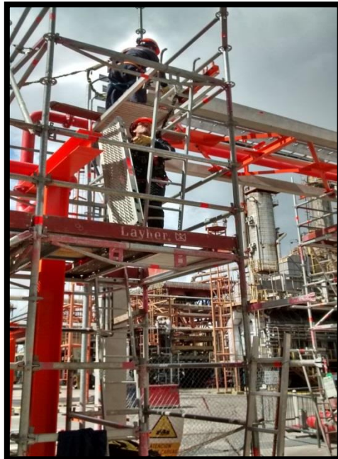
- Andamio para realizar acometida de bandejas a pileta 12 y completamiento de soporteria.
