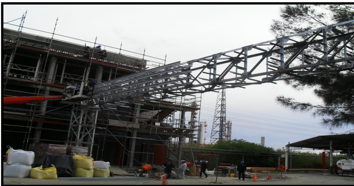
- Ajustes y Torque de estructura metálica, soportes y bandejas.
