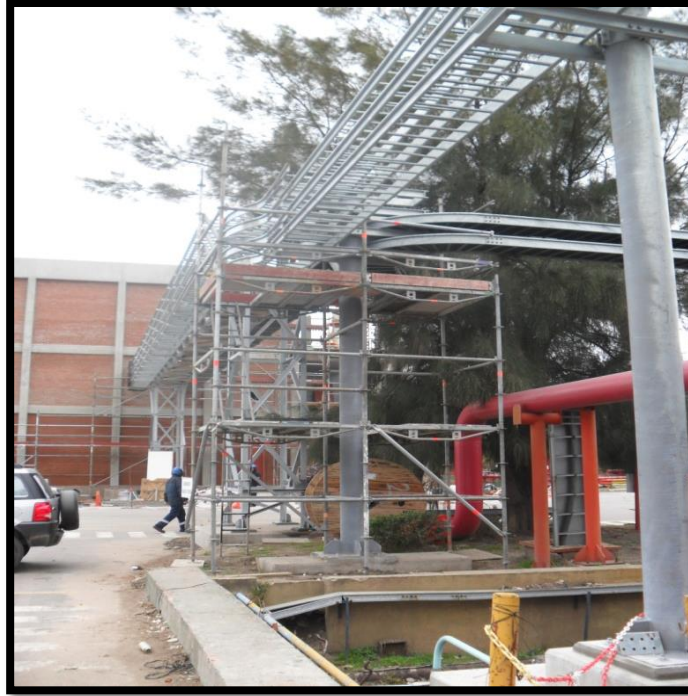
- Cruce de calle 102. Montaje de Bandejas en Cruce de calle.
