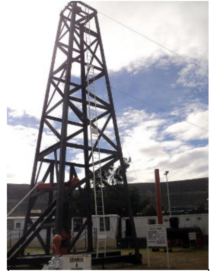
Imagen 1 - Primer equipo de perforación petrolero (1907), intacto en el museo del petróleo
