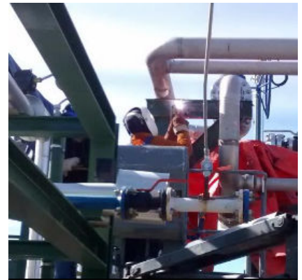
Imagen 4 – Trabajo en caliente, Soldadura de soporte en planta compresora de gas.
