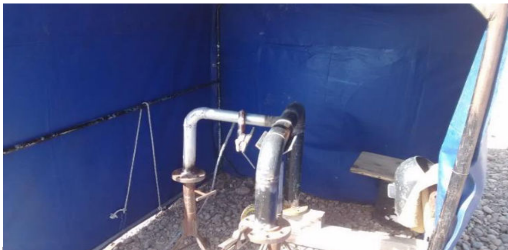
Imagen 13 – Interior de carpa de soldadura.
