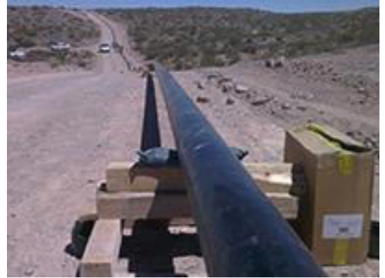
Imagen 2 – Ducto de 25km
