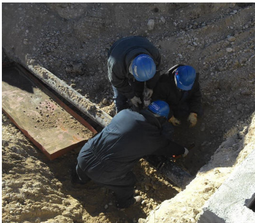
Imagen 15 - Corte en frío de cañería de 6" con cortatubos manual.
