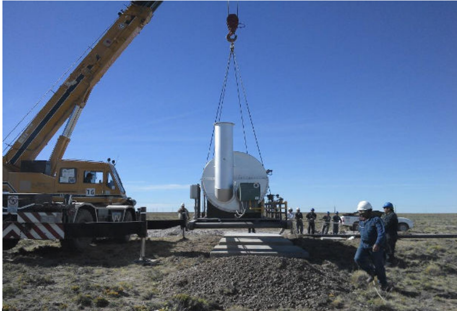
Imagen X – Montaje de calentador con grúa de 25t guiado por sogas.
