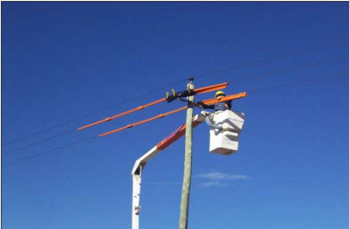
Cuando se trabaja en MT, ***“El trabajador se encuentra aislado del potencial de línea mediante un doble aislamiento”***.
