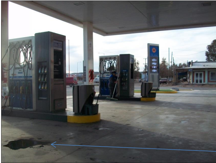
Derrames de combustibles en playa
