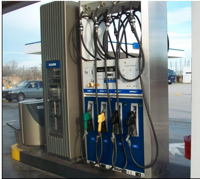
Surtidor Octuple tipo dispenser
