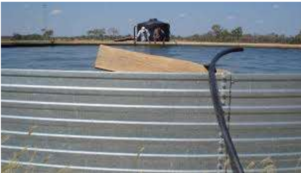
Tanque Australiano (chapa) capacidad de 500.000 Litros
