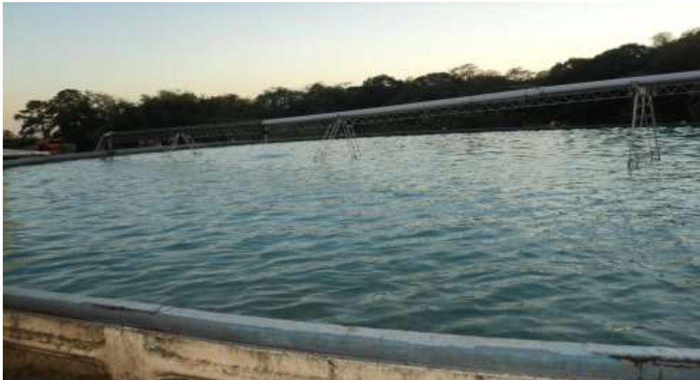
Tanque Australiano (material) capacidad de 500.000 Litros
