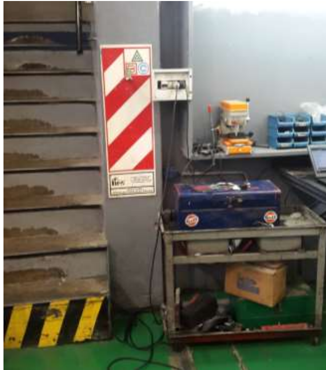
Figura 18: Chapa baliza sin extintor.
