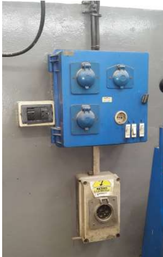
Figura 39: Tablero auxiliar.
