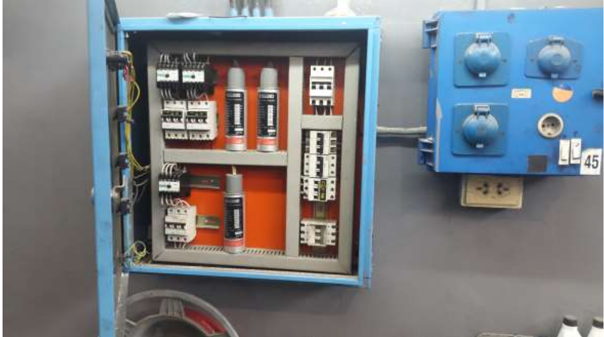
Figura 42: Tablero auxiliar
