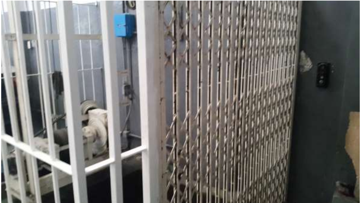
Figura 50: vista de la puerta del montacargas.
