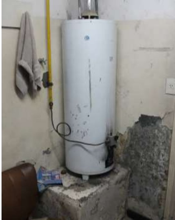
Figura 30: Termotanque.
