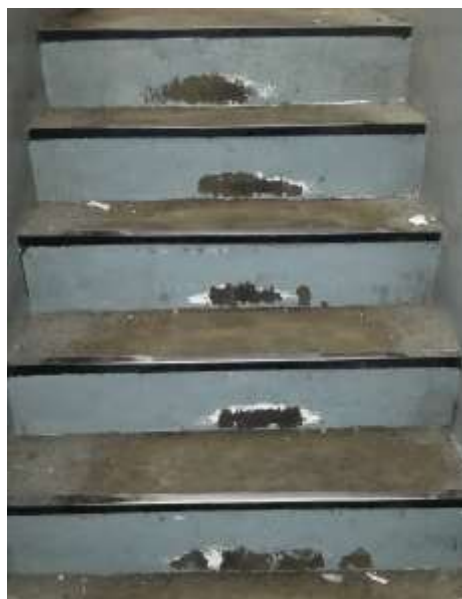
Figura 35: Escalera de acceso al vestuario.
