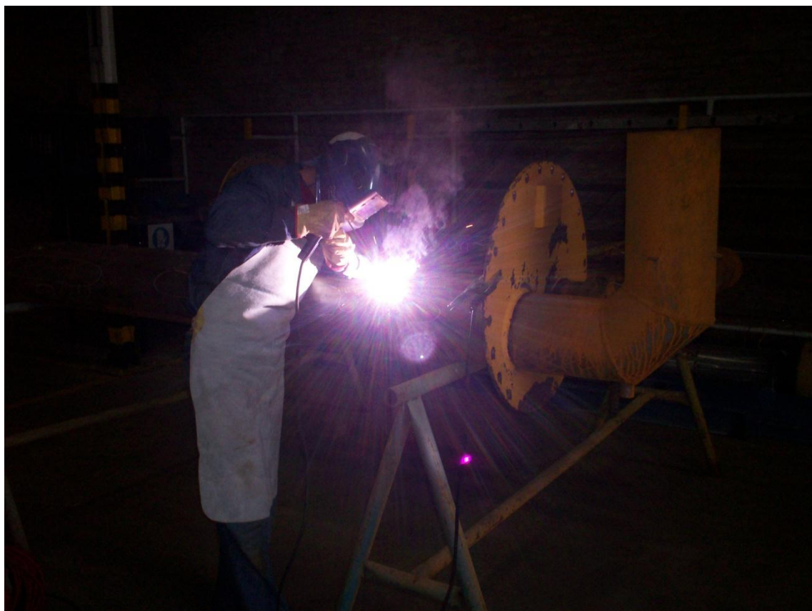
Figura 12 – Operario de Husal realizando Soldadura al Arco Eléctrico
