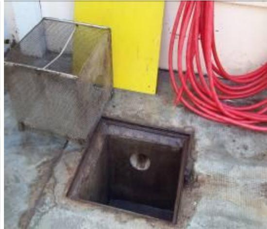
Imagen N°28. Cámara de inspección
