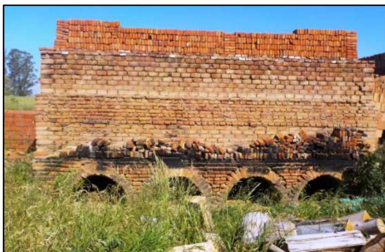
Figura 5.10. Vista posterior del horno. Se observan las bocas de alimentación de combustible.
