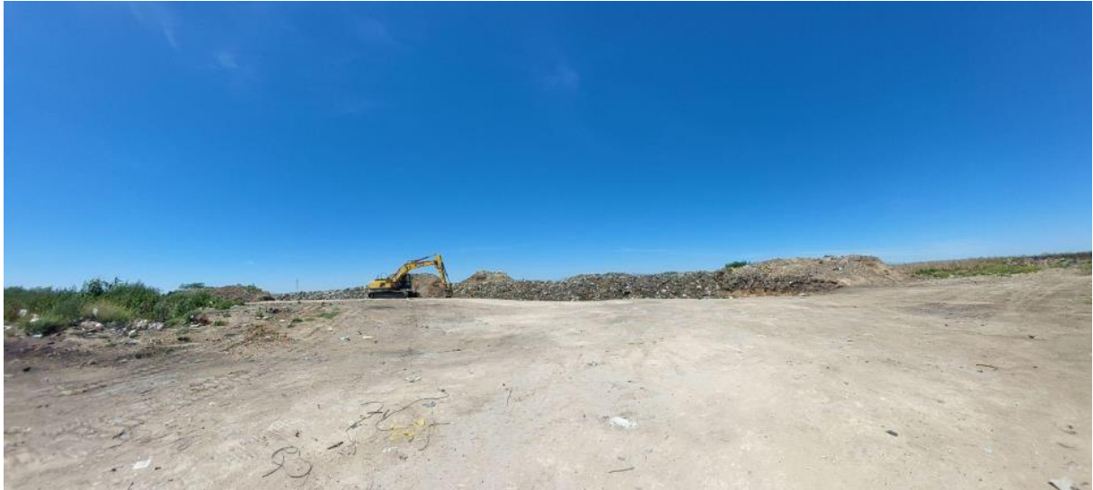
Imagen 13: Fotografía de la operatoria del basural luego de su saneamiento y reacondicionamiento. Fuente: Municipalidad de Lobería, 2022.
