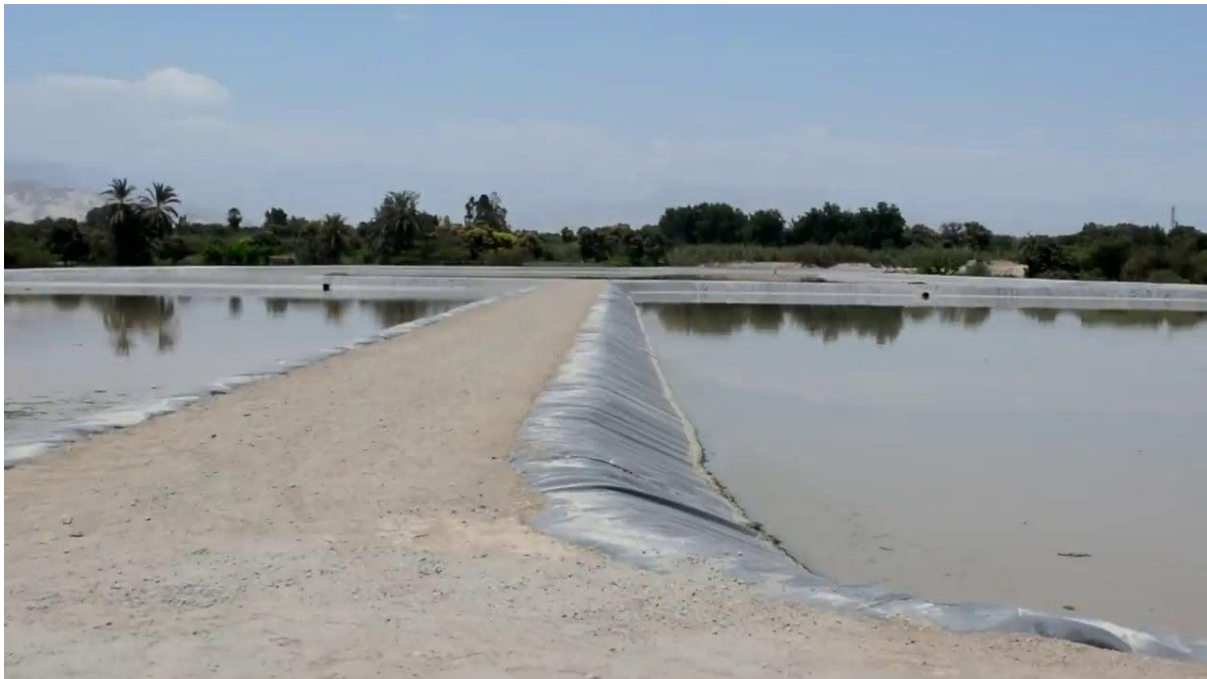
Ilustración 19: Sedimentador de tipo lagunar.
