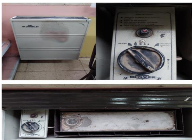
Imagen 7.12. Calefactor antiguo a gas propano. Fuente: Elaboración propia.
