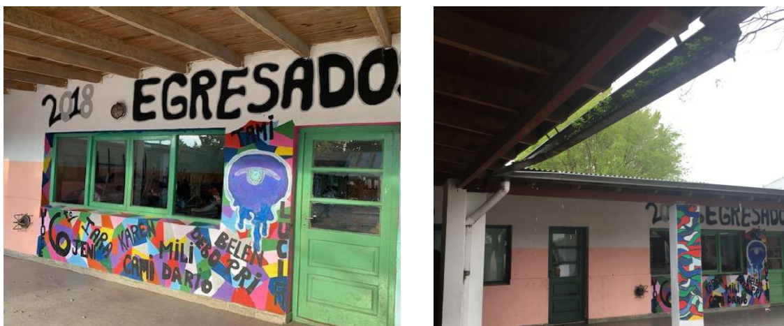
Imagen 7.3. Voladizo del techo, ventanas y puerta con vidrios. Fuente: Elaboración propia.
