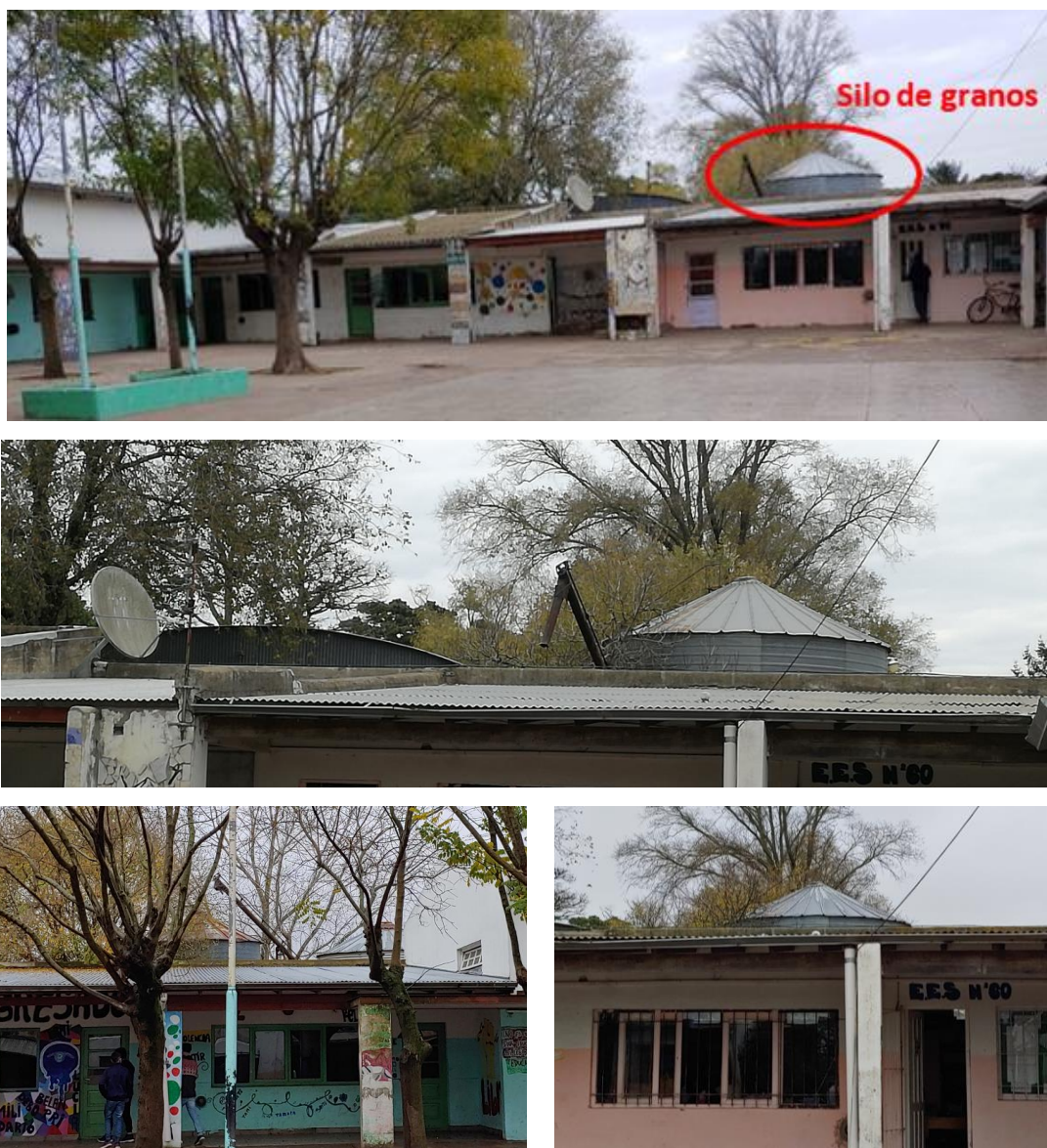
Imagen 7.13. Silos de granos. Fuente: Elaboración propia.
