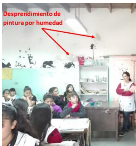
Imagen 7.6. Efecto de la humedad en las paredes de las aulas. Fuente: Elaboración propia.
