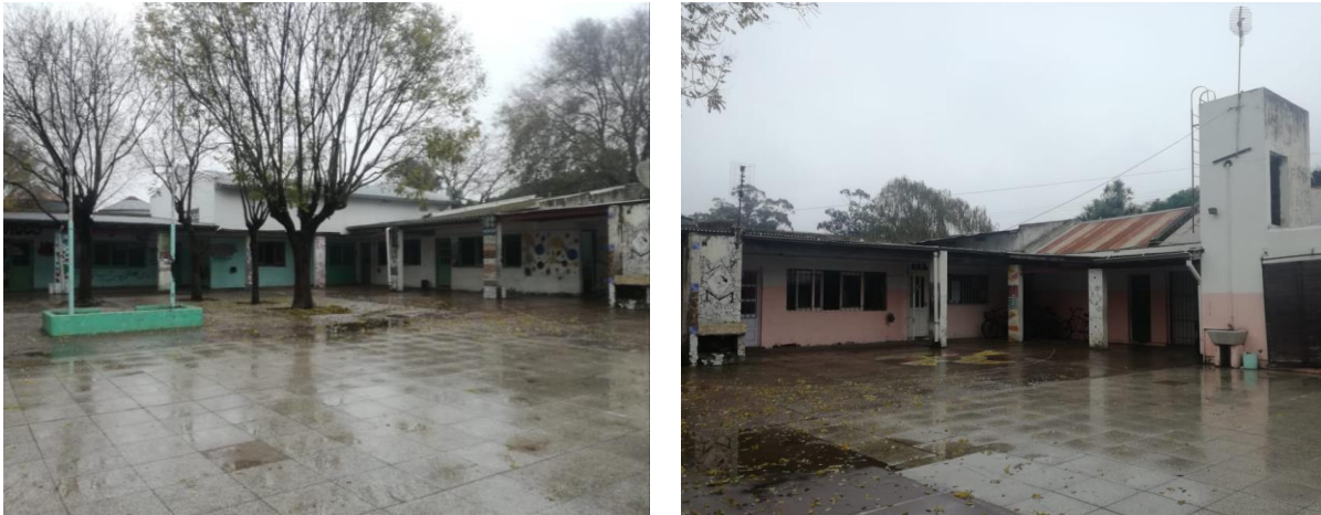
Imagen 7.19. Patio interno central con sectores anegados. Fuente: Elaboración propia.
