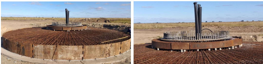
Figura 12. Jaula de pernos en el predio Cerro de la Gloria. Fuente: propia
