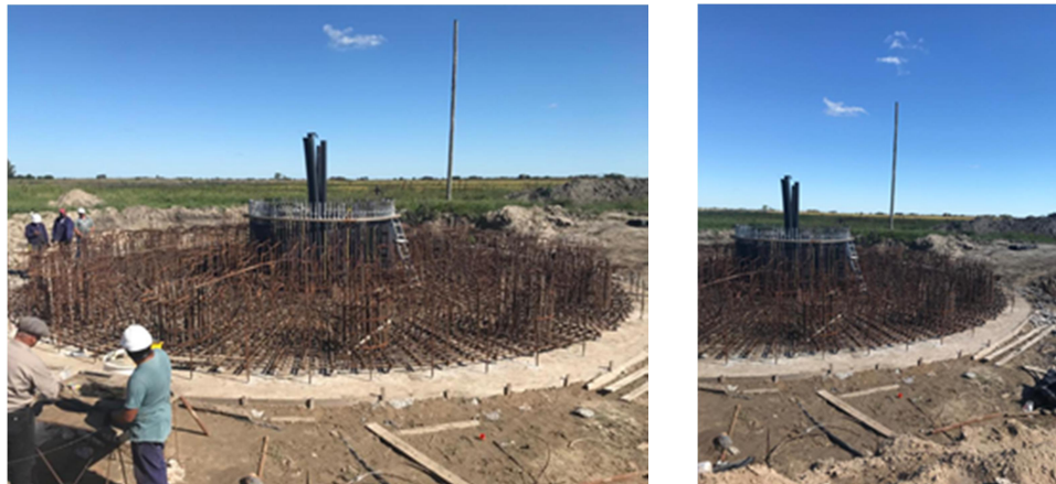
Figura 12. Jaula de pernos en el predio Cerro de la Gloria. Fuente: propia
