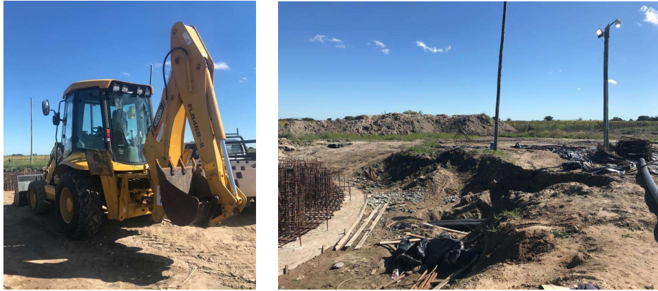
Figura 11. Excavación del pozo en el predio Cerro de la Gloria. Fuente: propia
