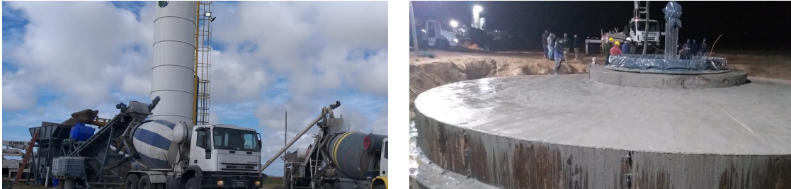
Figura 13. Cimentación de la zapata en el predio Cerro de la Gloria. Fuente: propia
