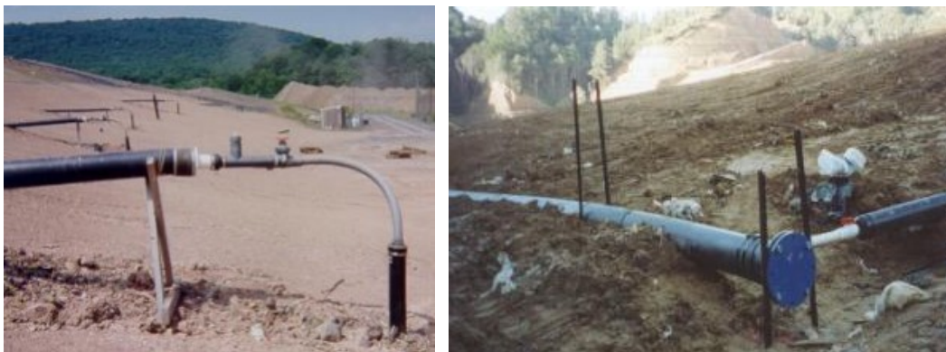
Imagen 16. Colectores horizontales (MethaneToMarkets)
