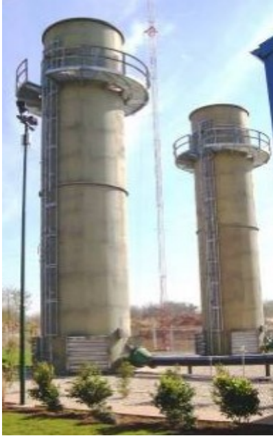
Imagen 23. Antorcha tipo “Cerrado” (Weihs-Biogas)
