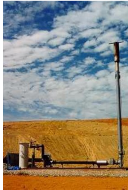
Imagen 23. Antorcha tipo “Cerrado” (Weihs-Biogas)
