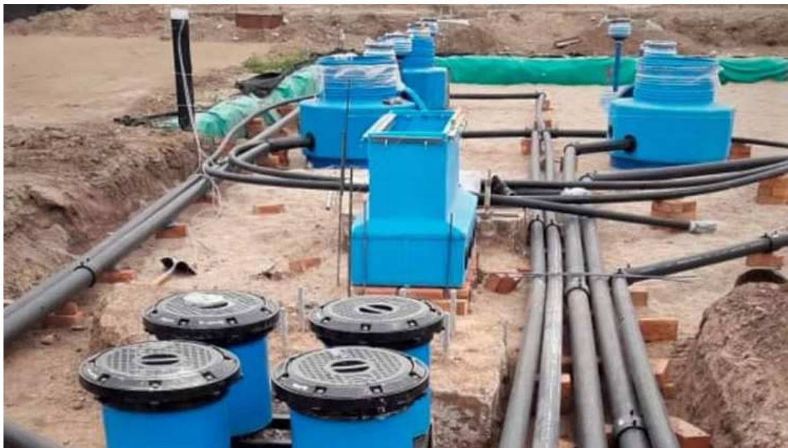
Montaje de componentes de una instalación SASH
