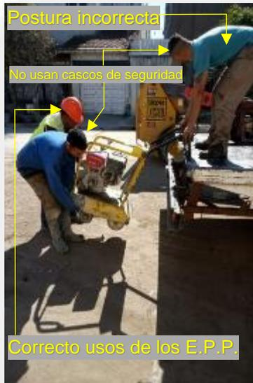
Imagen 11: Operarios descendiendo la máquina cortadora.
