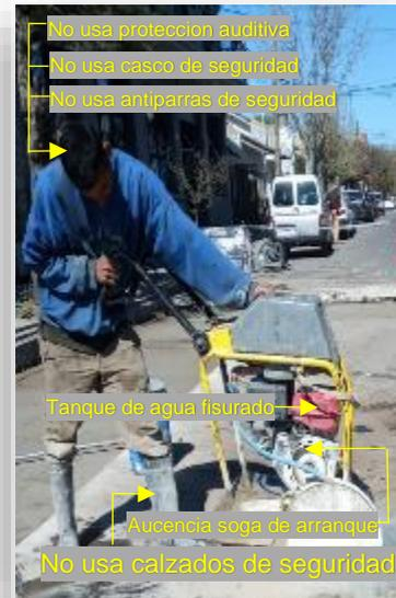
Imagen 13: Operario realizando corte de pavimento.
