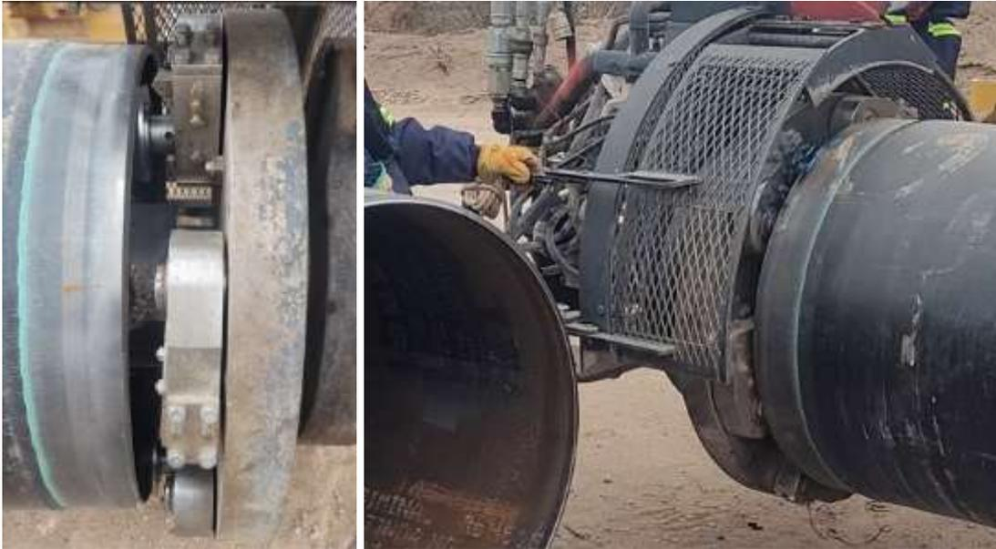
Se utiliza para modificar los biseles de acuerdo con el procedimiento de soldadura de doble junta. La biseladora frontal consta de fresas impulsadas por sistemas hidráulicos; esta máquina se introducirá en forma manual y se encontrará suspendida por un aparejo que regula su posición de trabajo.
