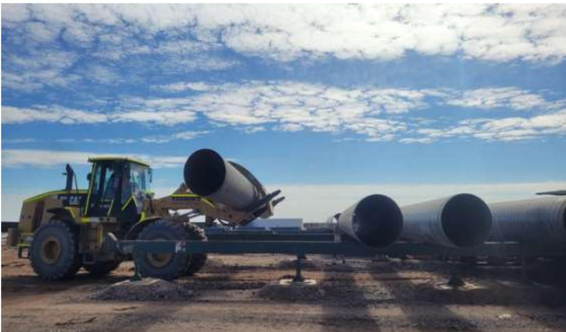
Es utilizado para trasladar los caños simples (12 m) de 36" desde el acopio hasta los bancales de la planta de soldadura (lado izquierdo y lado derecho). Para luego retirar los caños en doble junta (24 m) en la salida de la planta y acopiarlos.
