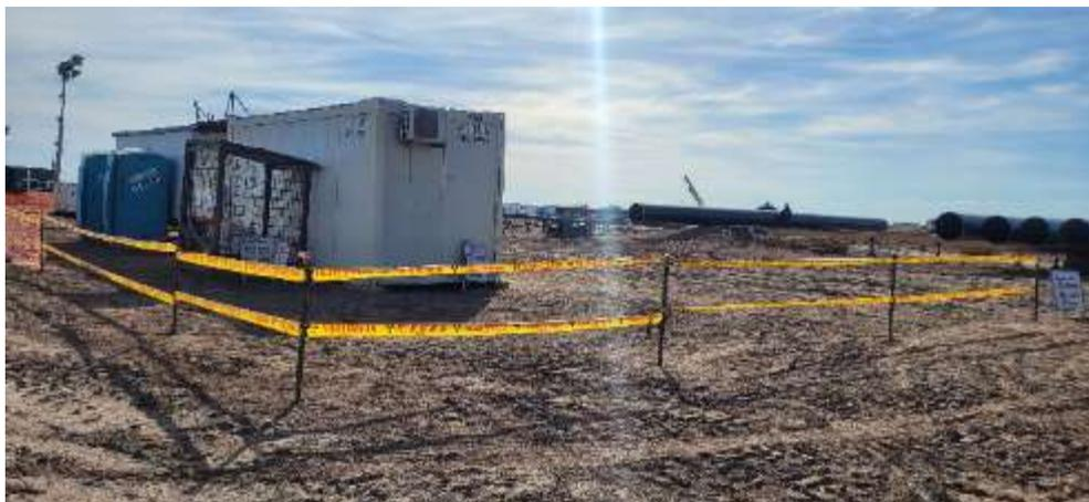
*El puesto de trabajo más cercano al área de gammagrafía es la tercera estación de soldadura, que se encuentra a una distancia de 27 m, por lo que se cumple con la distancia de seguridad. El resto del personal, ayudantes de soldadura, que se ocupan de la rotación de los caños con grifas, colocación de cuñas, etc. Deben retirarse fuera de vallado al momento de realizarse la exposición.*
