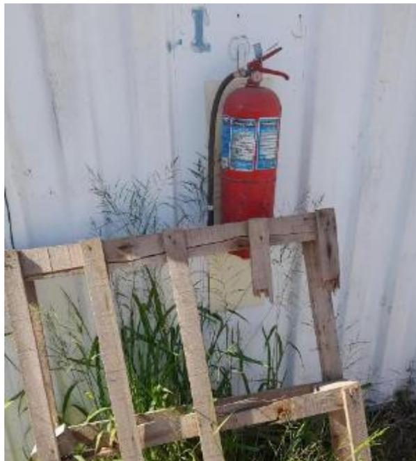
Extintor clase ABC 10Kg (se observa faltante de chapa baliza para señalización y obstruido por una tarima)
