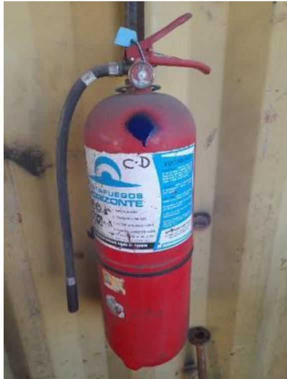
Extintor clase ABC 10Kg (se observa faltante de chapa baliza de señalización)
