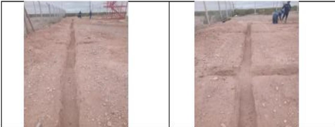
1) El cliente solicita que la excavación longitudinal se realice a una profundidad de 500 mm del nivel natural del terreno con el agregado de excavaciones manuales transversales cada 5000 mm una de la otra en el ancho de 2500mm los que nos pareció muy criterioso y lógico, tal como muestra las siguientes imágenes. Esta excavación nos permite liberar la traza para realizar escarificación mecánica.
