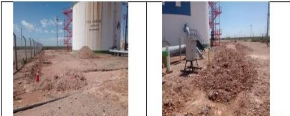
2) Superficialmente se escarifico los laterales Norte y Este del Tk Skimmer 001 B para luego ir perfilando y retirando el material excedente de la traza como muestran las siguientes imágenes.
