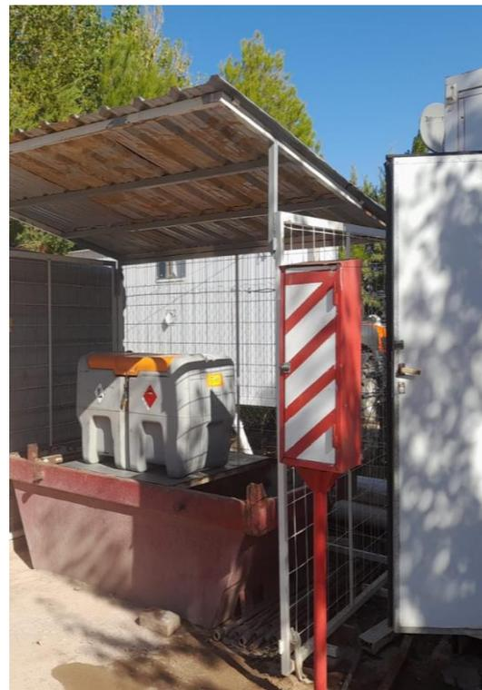
Los matafuegos manuales hasta 20 kg de masa total se instalarán de forma que su parte superior esté a una altura comprendida entre 1,2 m y 1,5 m del suelo. Todos se identificarán con un cartel reglamentario con franjas rojas y blancas a 45 grados, de 10 cm de ancho.
