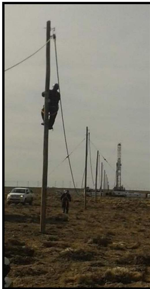
Imagen 2. Montador de Línea Eléctrica Aérea – Montaje del conductor sobre las roldanas.
