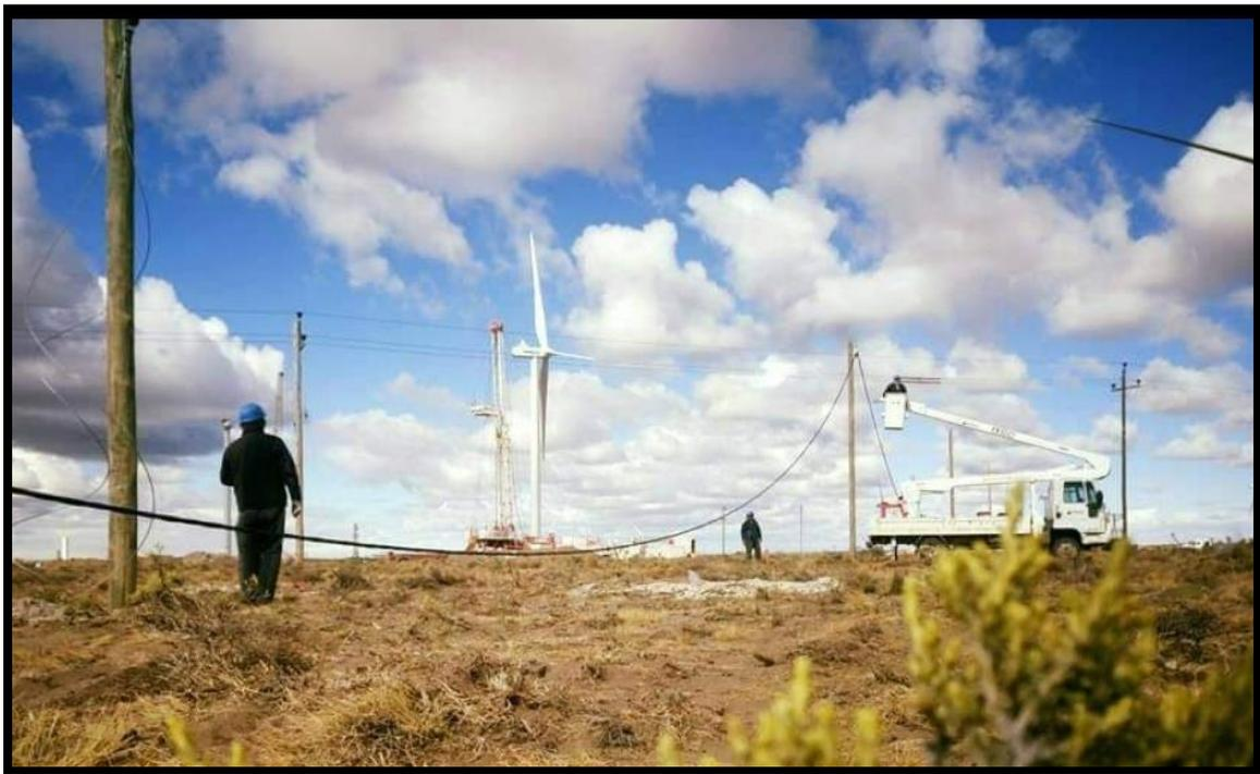
Imagen 3 -Hidro-elevador – flechado del conductor
