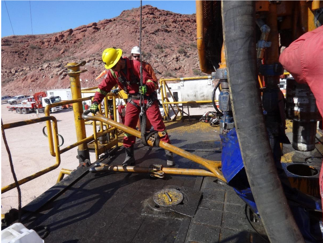
Winche usado como medio de izaje de piezas en montaje de TD
