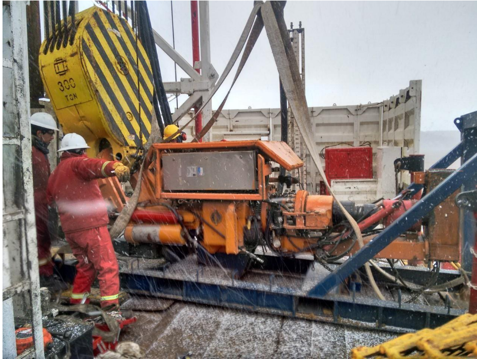
Izaje de TD con grúa
