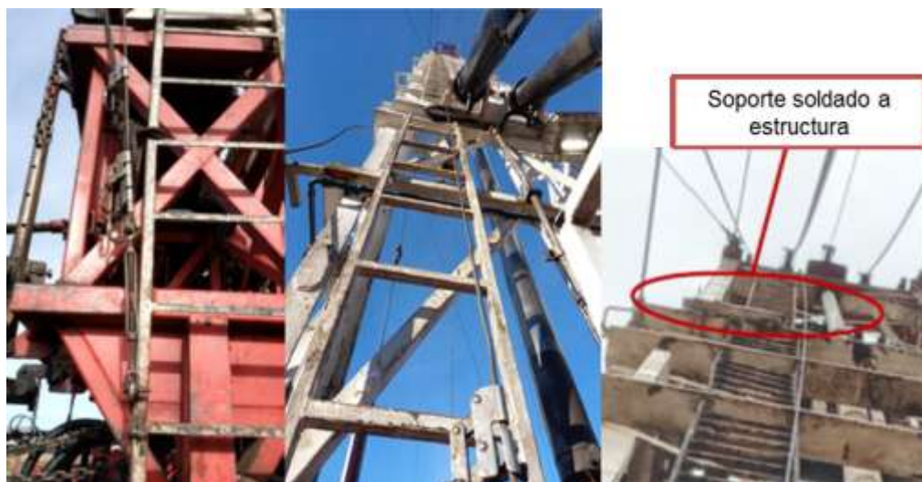
Figura 17 Sistema Anticaídas Montado sobre escalera
