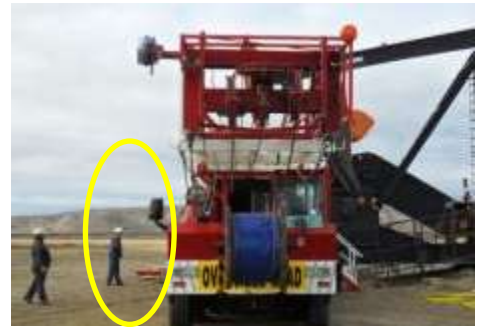
Figura 8 Enganchador actuando como señalero durante atracamiento de equipo
