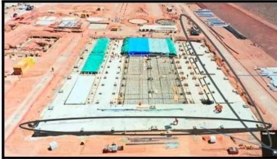
Vista del camino al área
