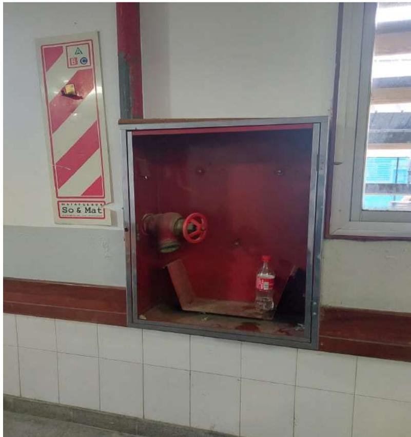
*(imagen n° 24 Gabinete Hidrante vacío)*
