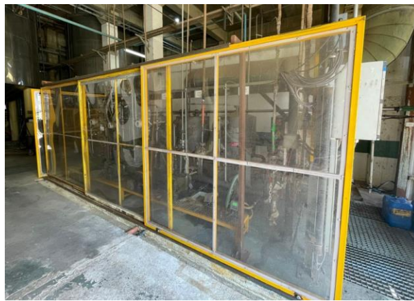
Foto 10. Dosificadores de gluco-milasa, alfa-milasa, hidróxido de sodio y ácido sulfúrico (vista con protección).
