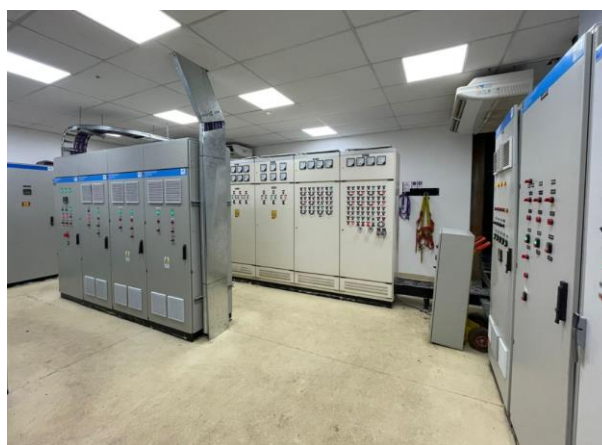
Foto 13. Sala CCM Licuefacción/Fermentación
